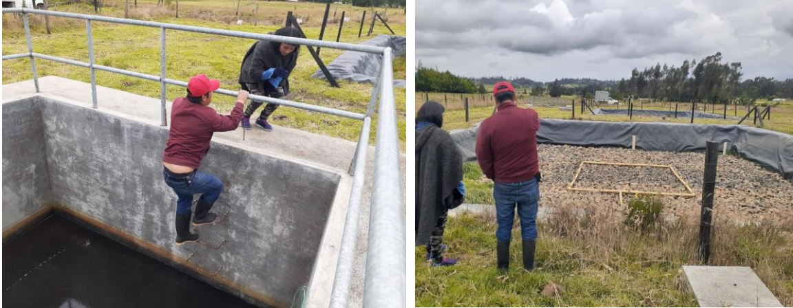
Ilustración 25: PTAR, aguas tratadas y utilizadas para beneficio de suelos Fuente: investigador
