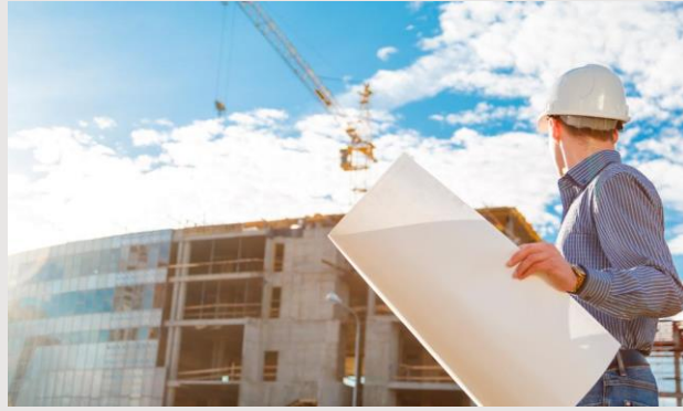
Figura 2 Construcción de edificaciones
