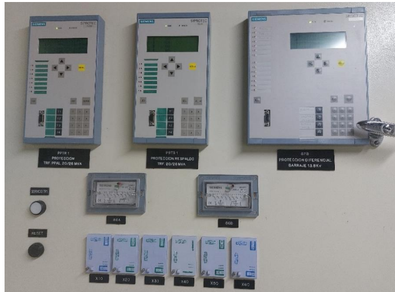
Figura 39. Tablero de protección inspeccionado en casa de máquinas.
