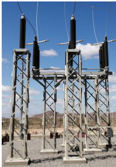
Figura 19. Seccionador Bypass.
