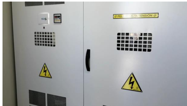
Figura 27. Transformador de servicios auxiliares tipo seco de 150 kVA.
