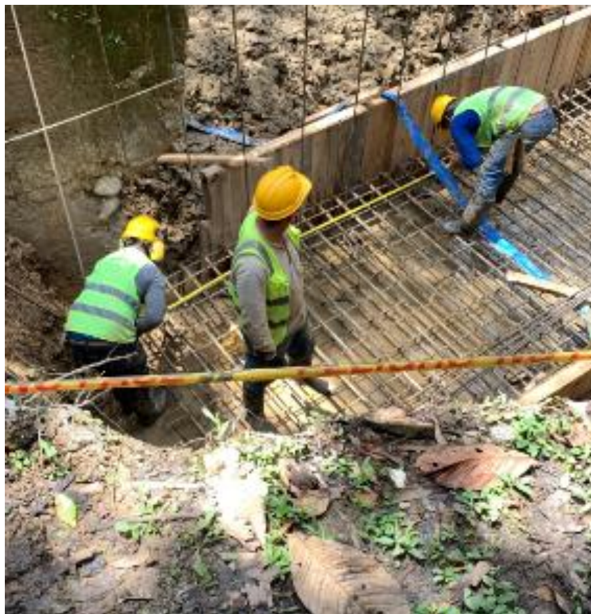
Figura 5 Armado de acero en la zapata
