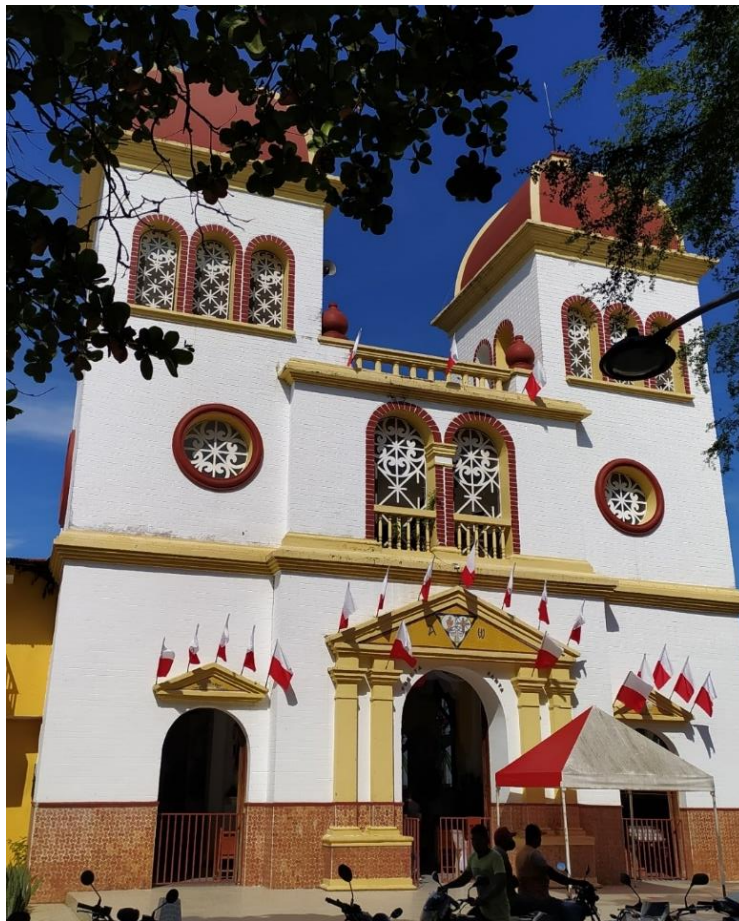
Figura 1. Parroquia Jesús Crucificado, ubicada en el parque central de Zaragoza
