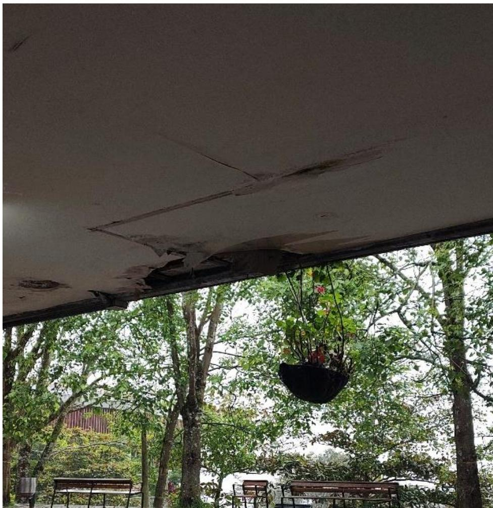
*Image 1 Humidité dans un toit du bâtiment.*
