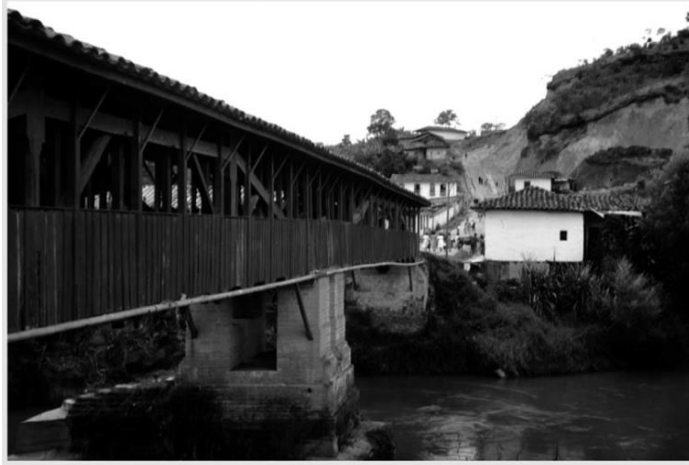
Figura 4. Casas aledañas al Puente Mejía.
