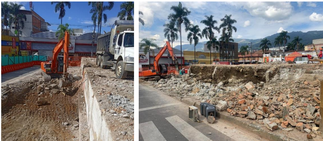
Figura 4 Antigua muro de contención
