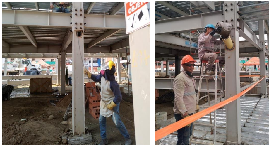
Figura 12 Vaciado manual de columnas metálicas
