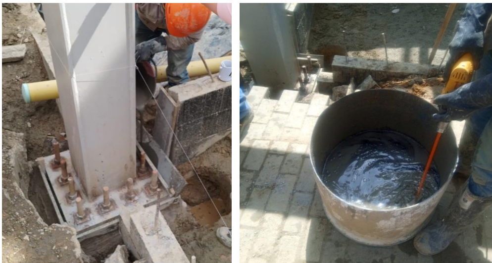
Figura 9 Vaciado de Grouting
