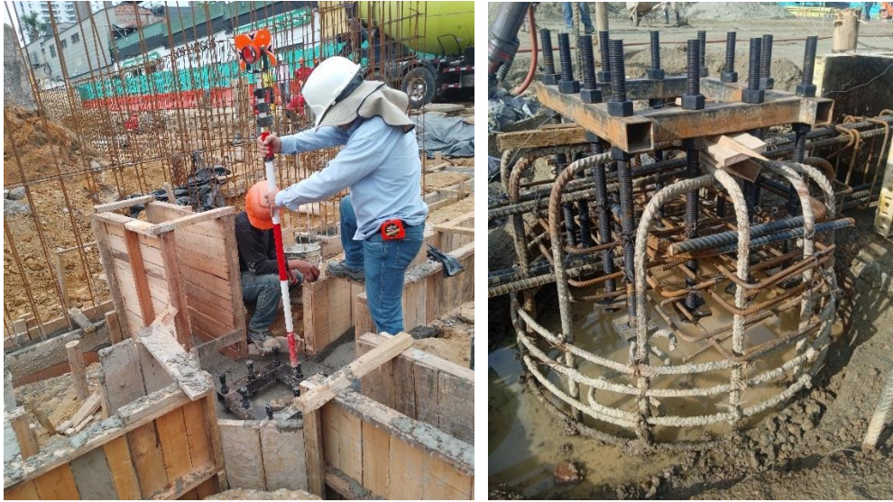
Figura 8 Verificación de platinas
