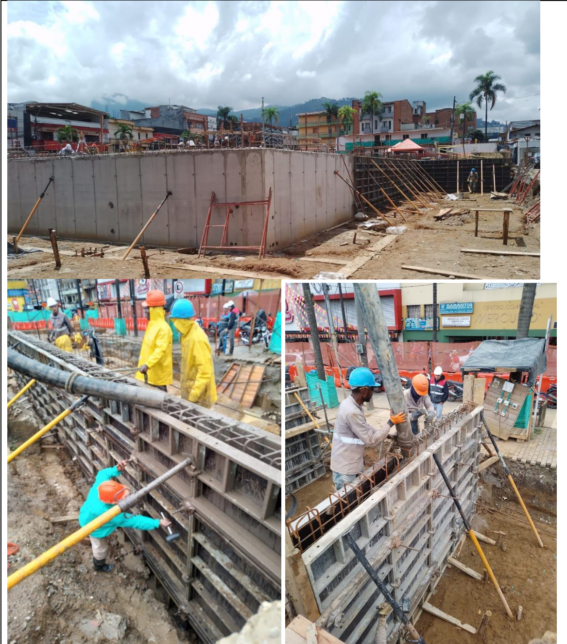
Impermeabilización y drenaje
