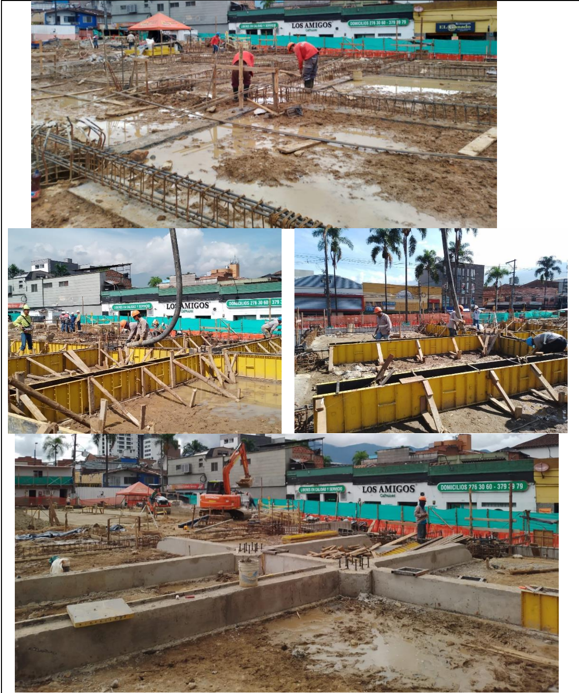
3. Muro de contención
