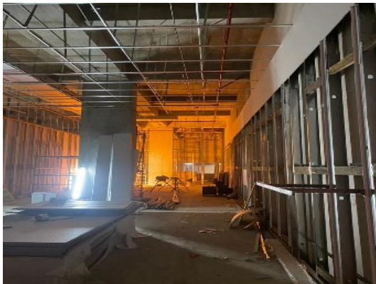
Ilustración 6. Instalación de estructura de sobremuro y cielos.
