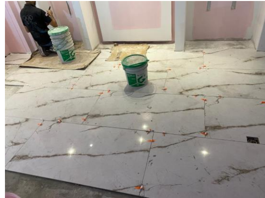
Ilustración 7. Vaciado de mortero de nivelación e instalación de piso en cerámica.
