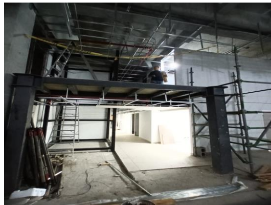
Ilustración 5. Instalación de Mezanine.
