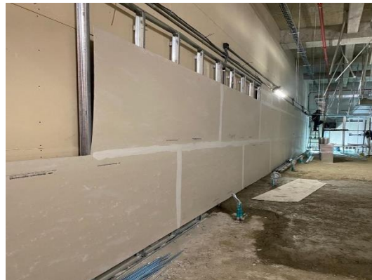
Ilustración 6. Instalación de estructura de sobremuro y cielos.
