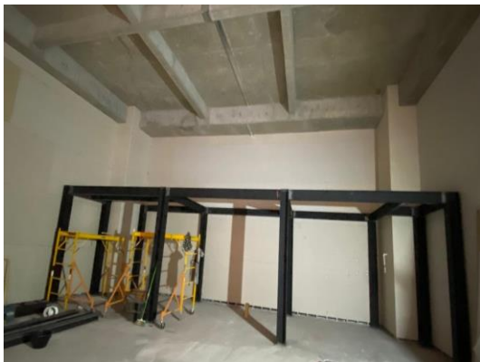
Ilustración 5. Instalación de Mezanine.
