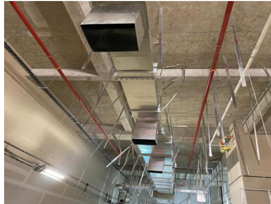
Ilustración 4. Instalación de RCI, red eléctrica, red de voz y datos y ductos de aire acondicionado.
