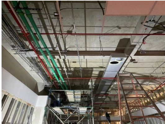
Ilustración 4. Instalación de RCI, red eléctrica, red de voz y datos y ductos de aire acondicionado.
