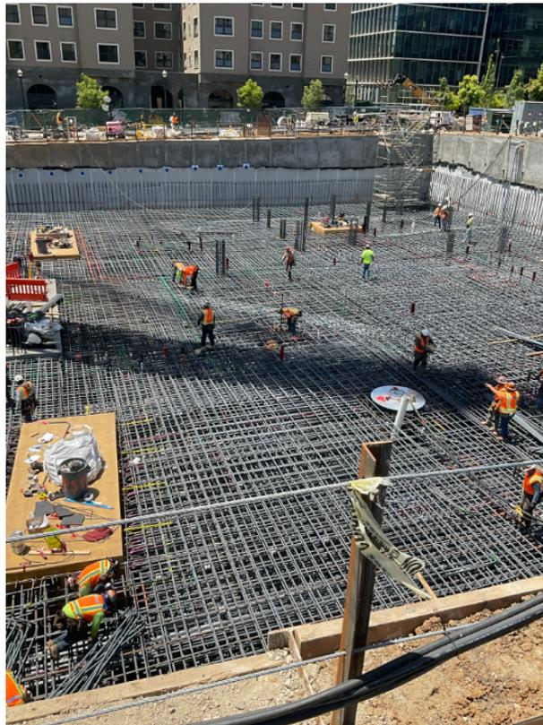
*Figura 2. Construcción de la losa de fundación.*
