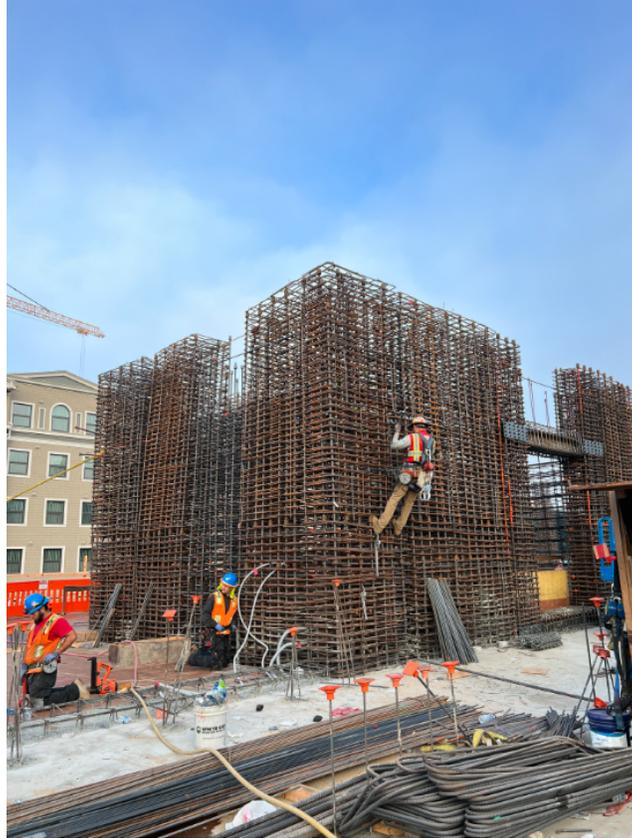
*Figura 3. Construcción de un núcleo.*
