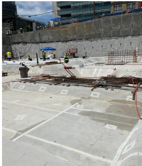
*Figura 1. Impermeabilización de la base de fundación.*
