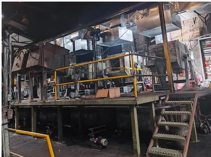
Figura 23. Inicio de instalación de pasamanos en plataforma.
