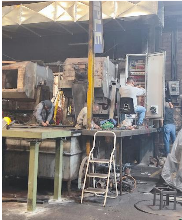
Figura 18. Inicio de instalación de tablero eléctrico.
