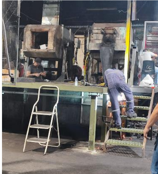
Figura 20. Construcción de escaleras de acceso a la plataforma.
