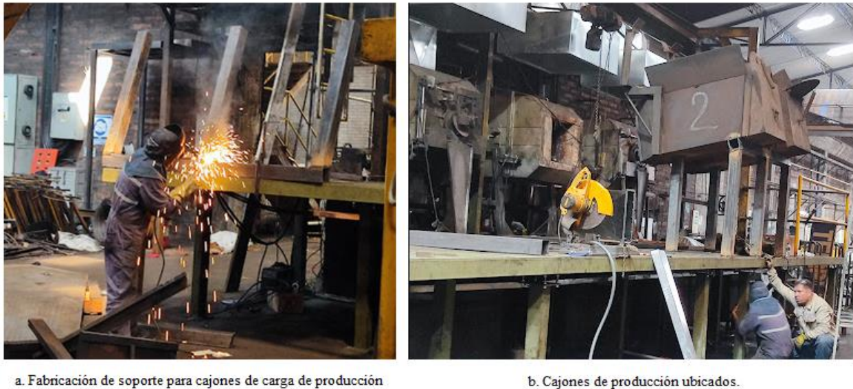
Figura 22. Instalación de cajones de carga de producción.
