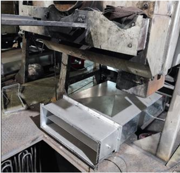
a. Boquilla para extracción de humos en canastillas de temple.
