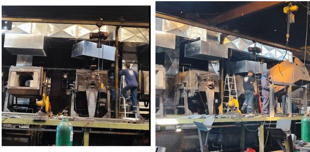
Figura 21. Instalación de campanas de extracción.
