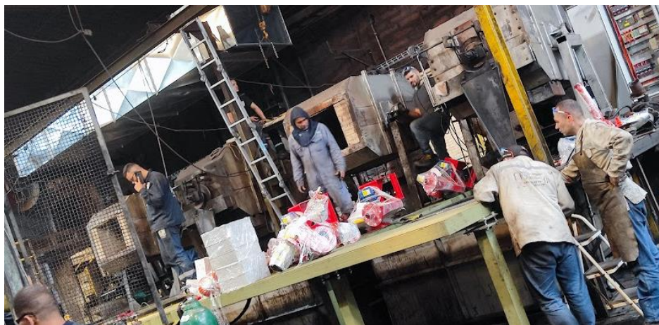
Figura 17. Inicio de instalación de quemadores.
