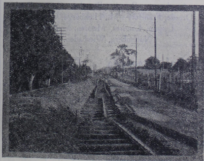
CONSTRUCCI N DE UNA NUEVA CARRILERA.
