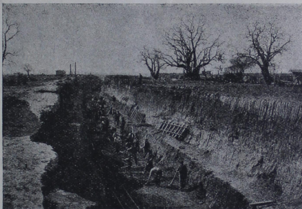
PROGRESO DEL TRABAJO EN UNA CORTADURA. FERROCARRIL CENTRAL DE BUENOS AIRES.
