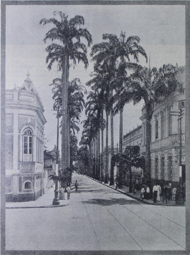
DOBLE CARRILERA EN UNA AVENIDA DE PALMAS EN PAR .
