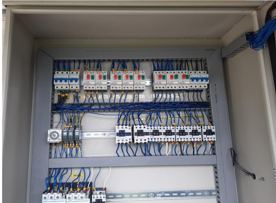
Figura 10. Gabinete de control petar
