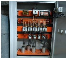
Fig. 31. Banco automático de condensadores
