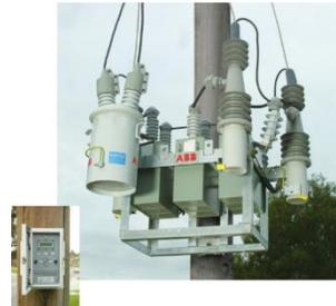
Fig. 34. Banco automático de condensadores tipo poste - MT
