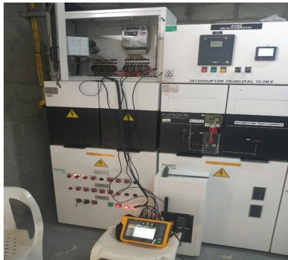
Fig. 5. Conexión analizador Celda de medida
