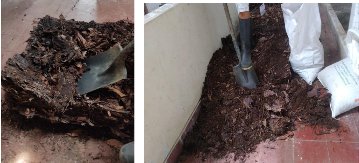
Fig. 18 Desmontaje de pacas biodigestoras
