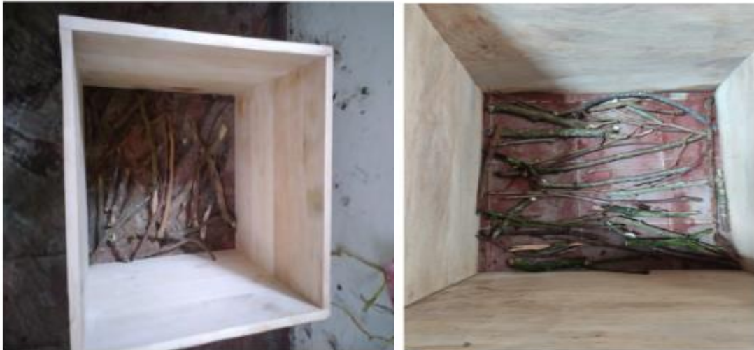
Fig. 8 Capa de ramas secas y delgadas en la base de la formaleta
