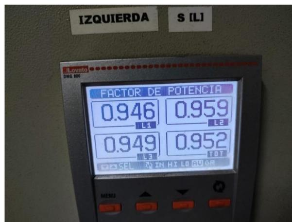
Fig. 3. Factor de potencia analizador de redes DMG 800.
