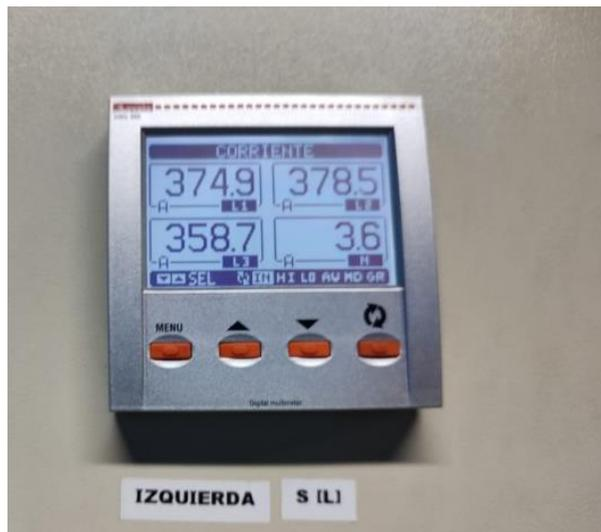
Fig. 4. Corriente analizador de redes DMG 800.
