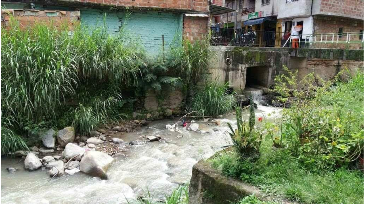
Figura 38. Registro fotográfico de factores que inciden en la presencia de olores en zonas de estudio, Comunas 8, 9 y 10, Medellín, 2017.
