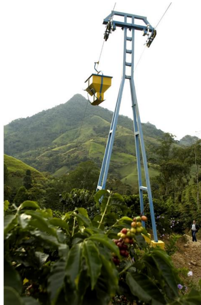
Figura 2. Torre de Sistema de transporte por cable para café
