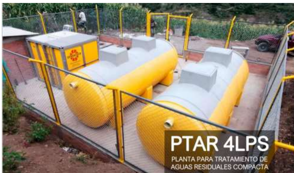
Ilustración 8: PTARD compacta (4LPS).
