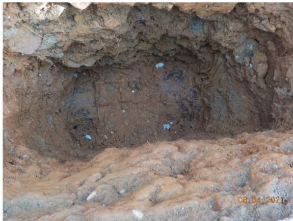
**Figura 7. Nicho N°499 Material Asbesto Cemento, diámetro 400mm**
