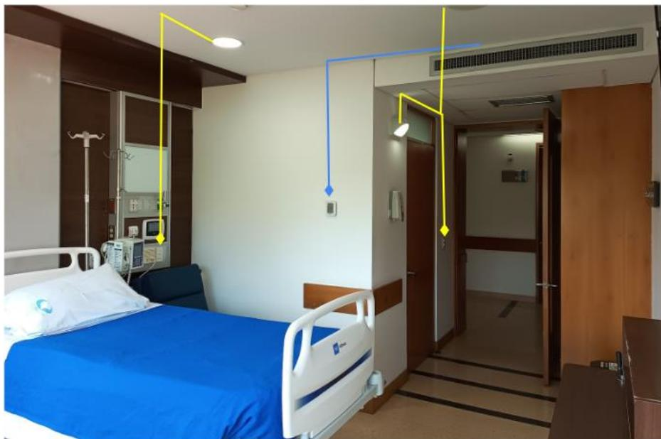
Fig. 5. Distribución de los elementos de control del aire (azul) y luces (amarillo) dentro de la habitación.
