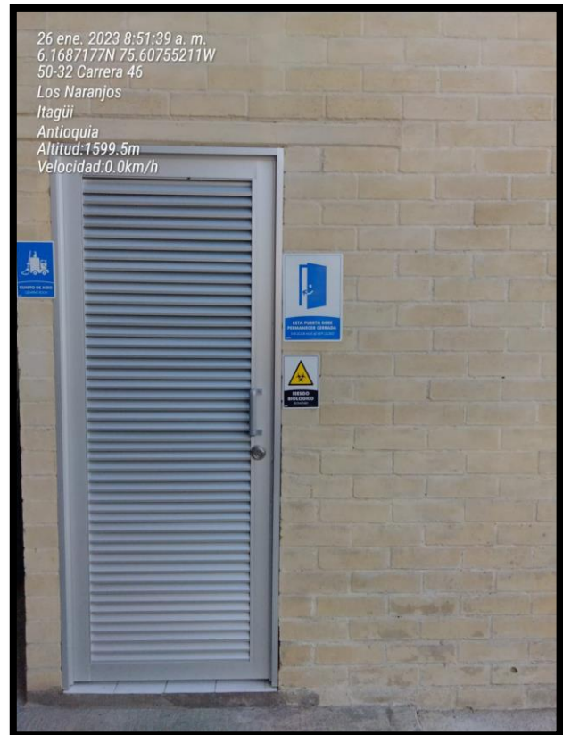
Fotografía. Cuarto de acopio de residuos peligrosos hospitalarios.
