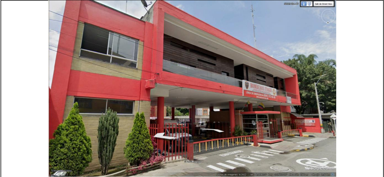
Fotografía 1. Estación Cuerpo de Bomberos Voluntarios de Itagüi
