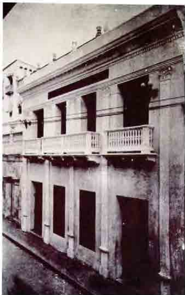
Fachada del edificio del diario cartagenero El Porvenir (Montoya Márquez, 1927).
