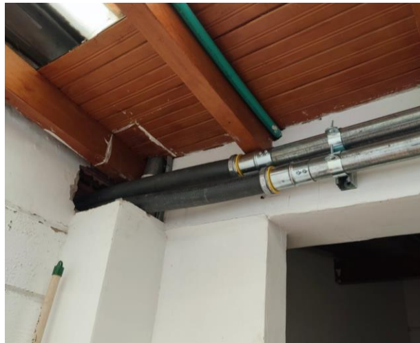
Imagen 36. Interventoría obras Hospital San Juan de Dios El Santuario.
