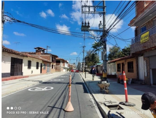
Imagen 2. Cra. 19 con el montaje de luminarias.
