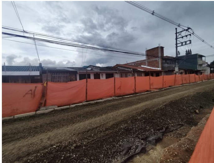
Imagen 1. Cra. 19 en construcción.
