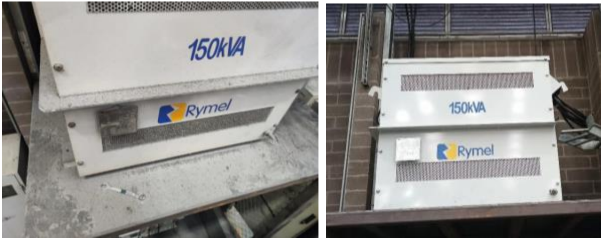
Fig. 9. Transformador de 150 kVA antes y después del mantenimiento
