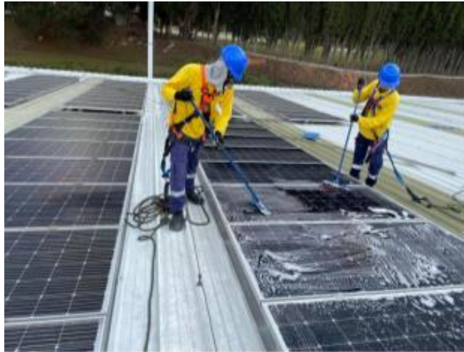
Fig. 3. Limpieza de módulos solares
