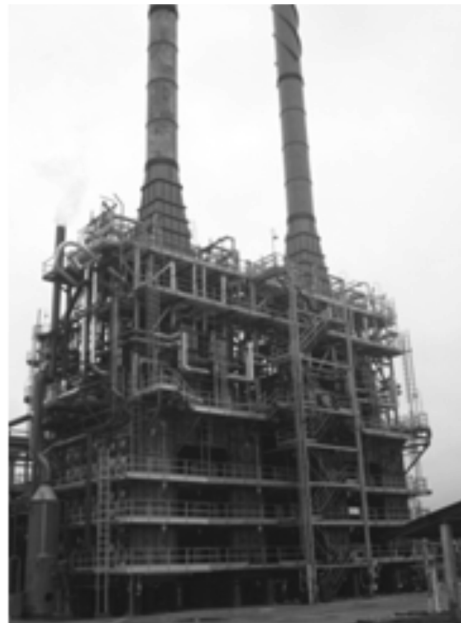
Figura 1. Horno de pirólisis de etano para producción de etileno
