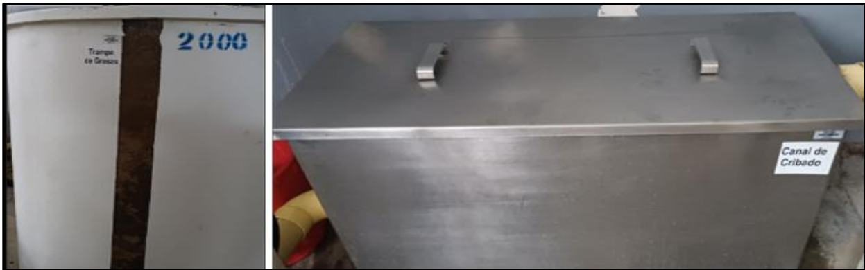
Figura 7 Trampa de grasa y trampa se sólidos
