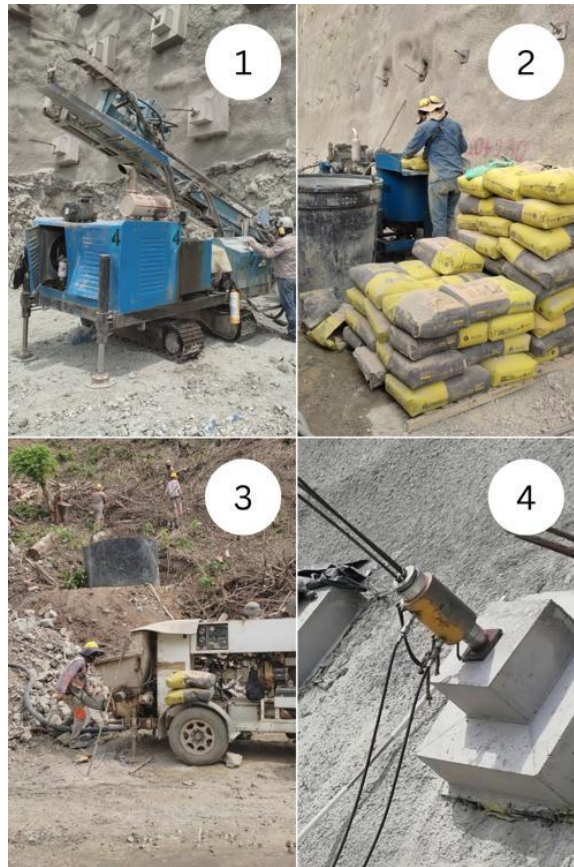
Ilustración 18, maquinaria para la construcción de anclajes. Fuente: elaboración propia
