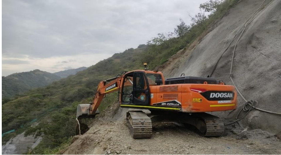
Ilustración 24, Corte y excavación de talud. Fuente: elaboración propia
