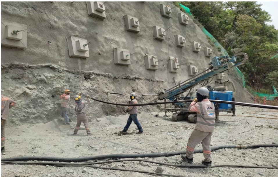
Ilustración 11, introducción de anclaje activo. Fuente: elaboración propia
