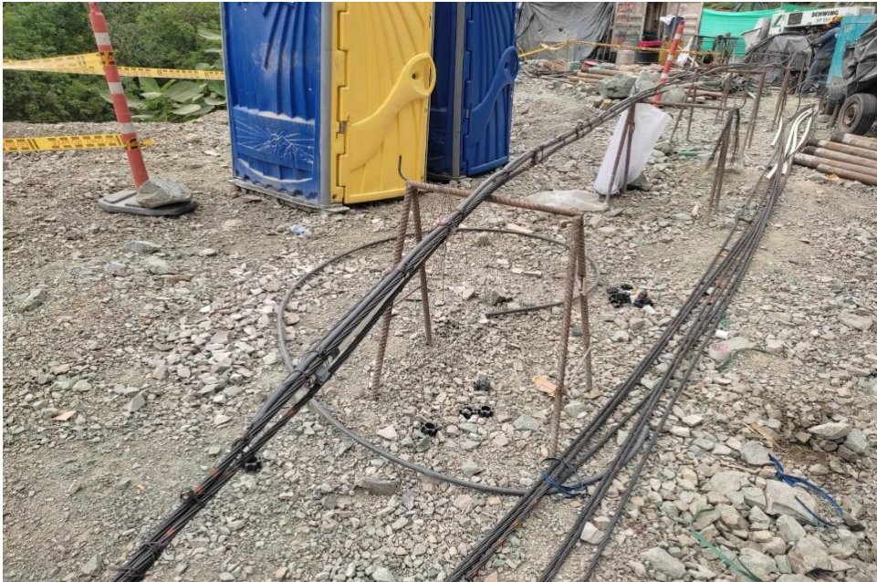
Ilustración 5, Armado de anclajes activos. Fuente: elaboración propia
