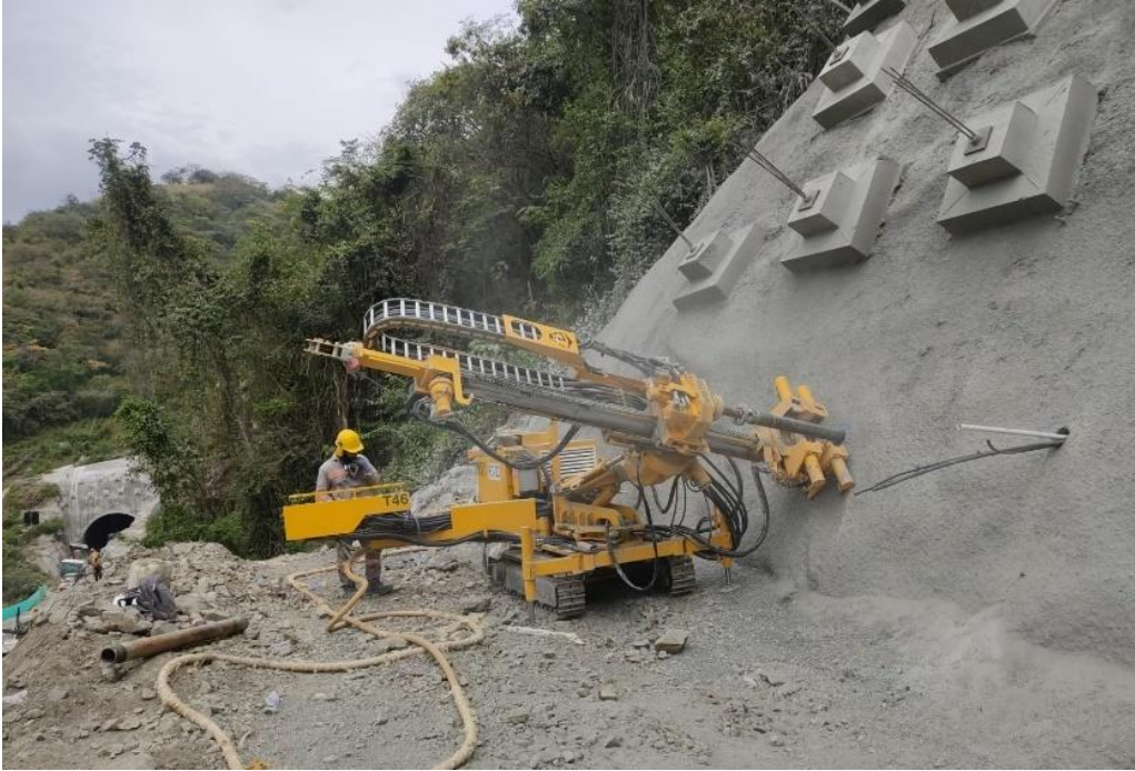
Ilustración 26, perforación de anclajes. Fuente: elaboración propia
