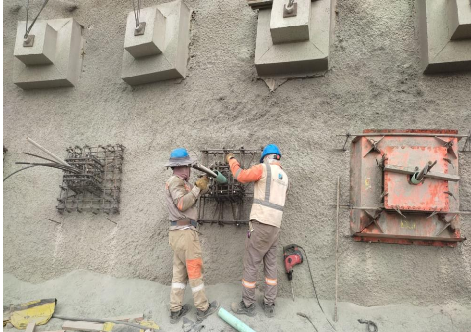
Ilustración 13, Instalación de refuerzo para dados de anclajes activo. Fuente: elaboración propia
