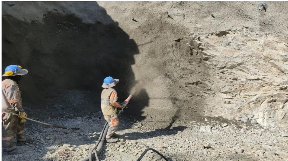
Ilustración 25, lanzado de concreto en Túnel 2. Fuente: elaboración propia
