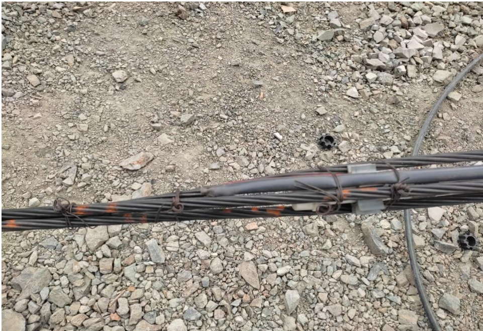
Ilustración 6, Punta de anclaje activo. Fuente: elaboración propia
