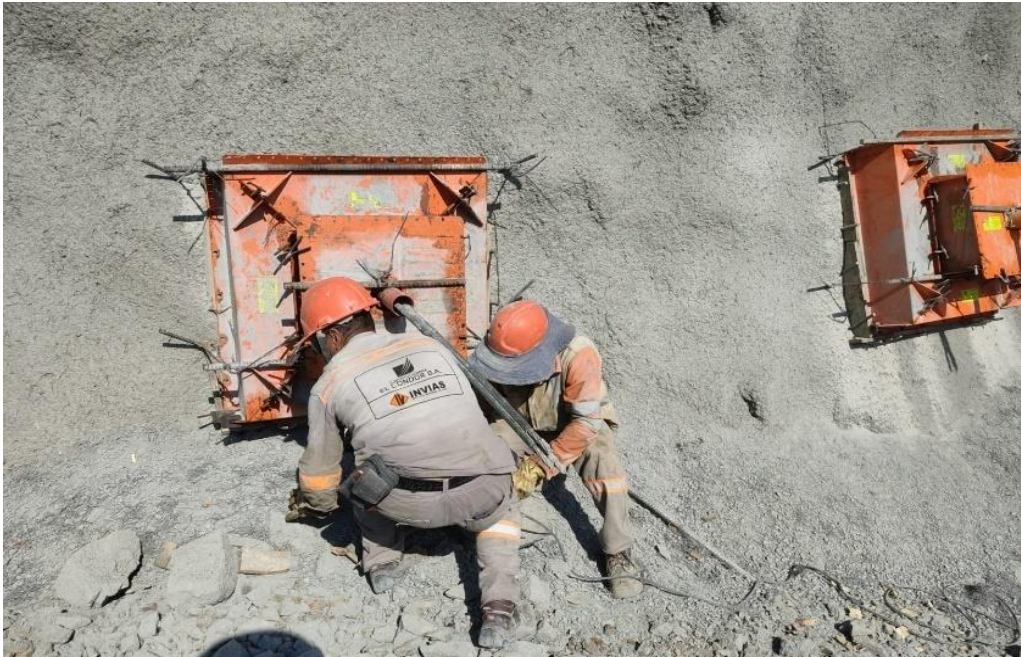
Ilustración 30, Construcción de dado. Fuente: elaboración propia
