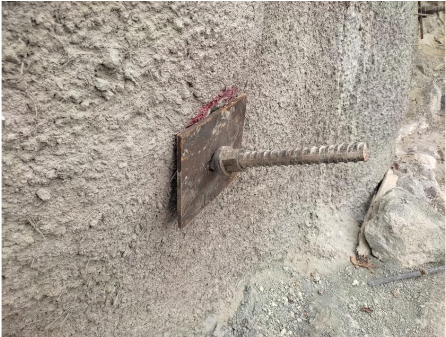
Ilustración 16.1, anclaje pasivo terminado. Fuente: elaboración propia
