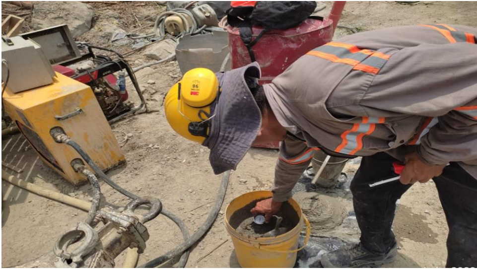
Ilustración 9, Toma de temperatura de concreto. Fuente: elaboración propia
