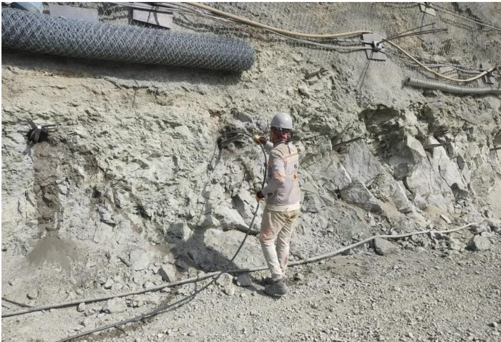
Ilustración 29, Inyección de anclajes pasivos. Fuente: elaboración propia
