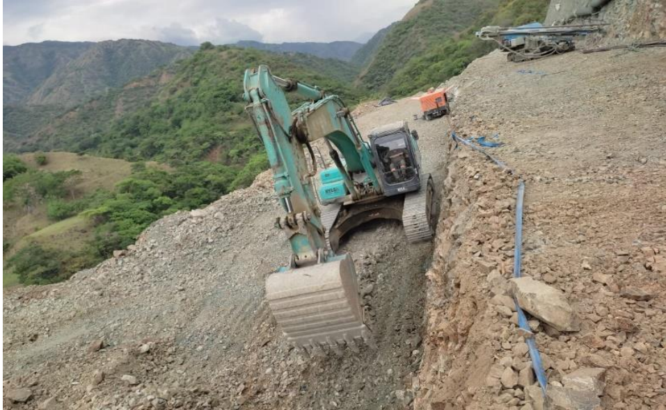
Ilustración 7, Perfilado y excavación de talud. Fuente: elaboración propia
