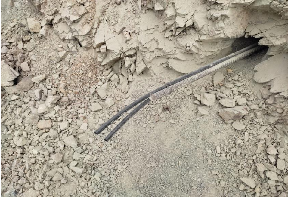
Ilustración 17, anclaje pasivo sin platina. Fuente: elaboración propia
