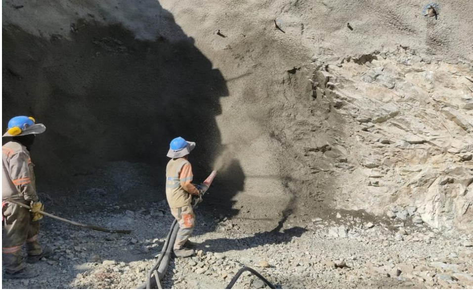
Ilustración 10, Lanzado de concreto. Fuente: elaboración propia
