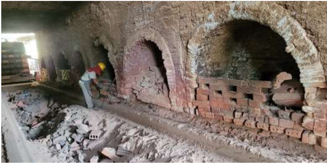
Figura 22. Personal en mantenimiento preventivo de hornos / inspección visual.
