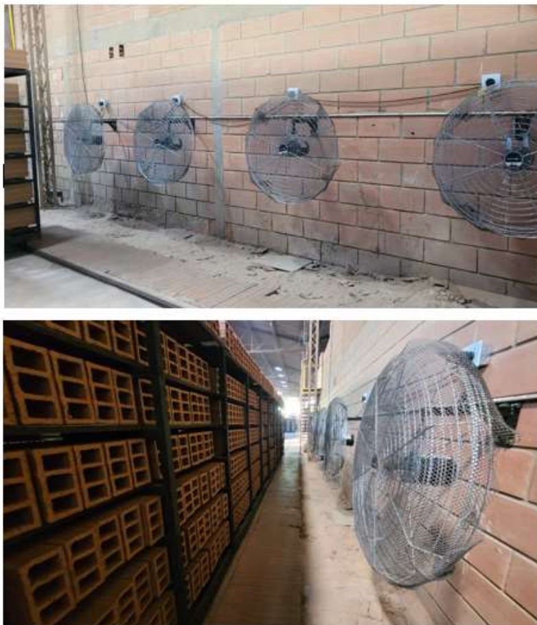
Figura 19. Montaje de ventiladores para el proceso de secado a temperatura ambiente.
