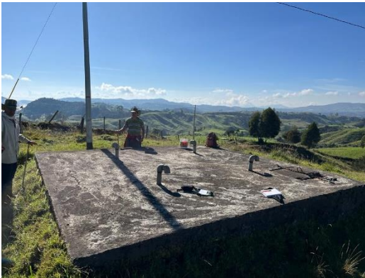
Tanque de almacenamiento del acueducto.
