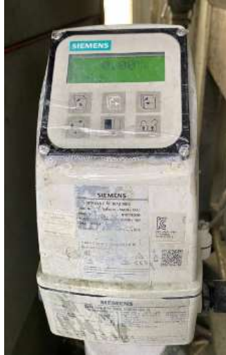
Figura 9. Sensor-transmisor de flujo. Figura 10. Bomba coagulante. Figura 11. Bomba de floculante.
