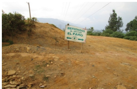
Caminos destapados, sector El Faro
