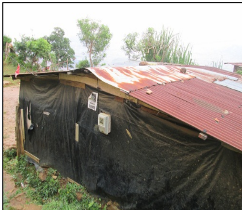
Viviendas sector El Faro
