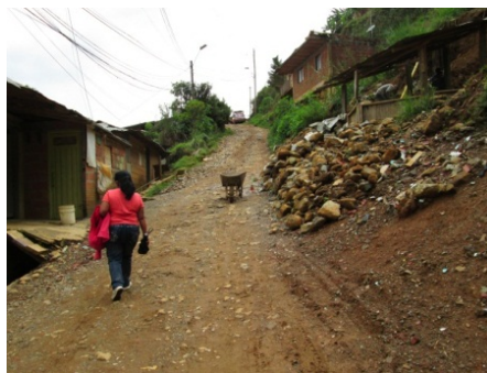
Caminos destapados 2 sector El Faro
