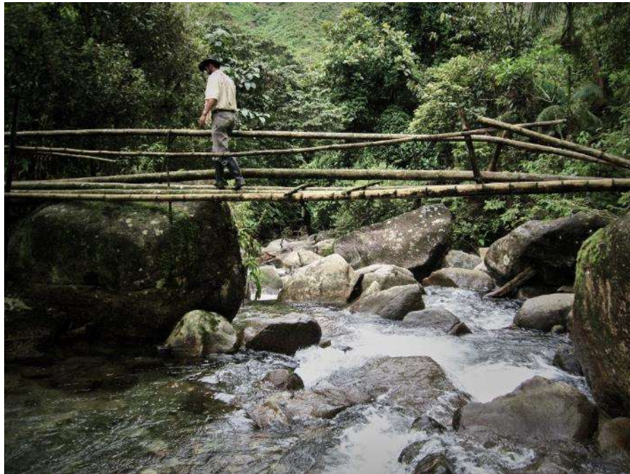
Figura 10 Puente sobre el Río Melcocho
