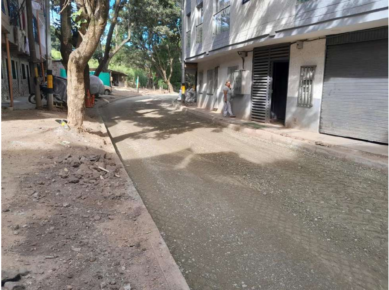
Figura 17: Base granular instalada y nivelada.
