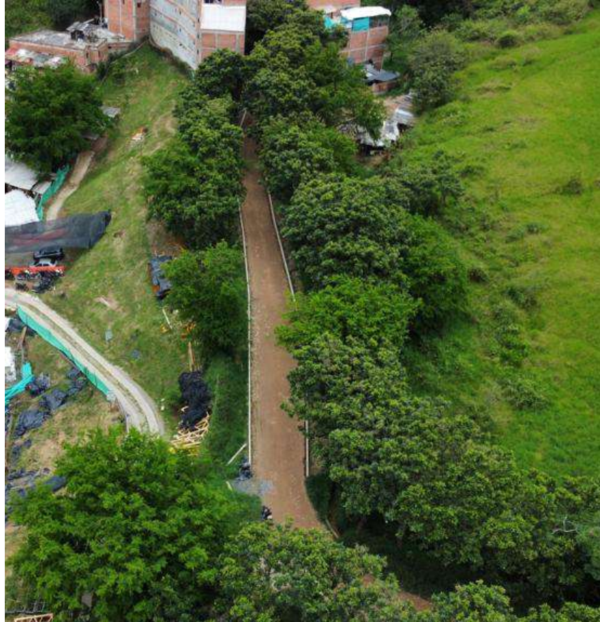
Figura 15: Vista superior de la vía con cordones instalados.
