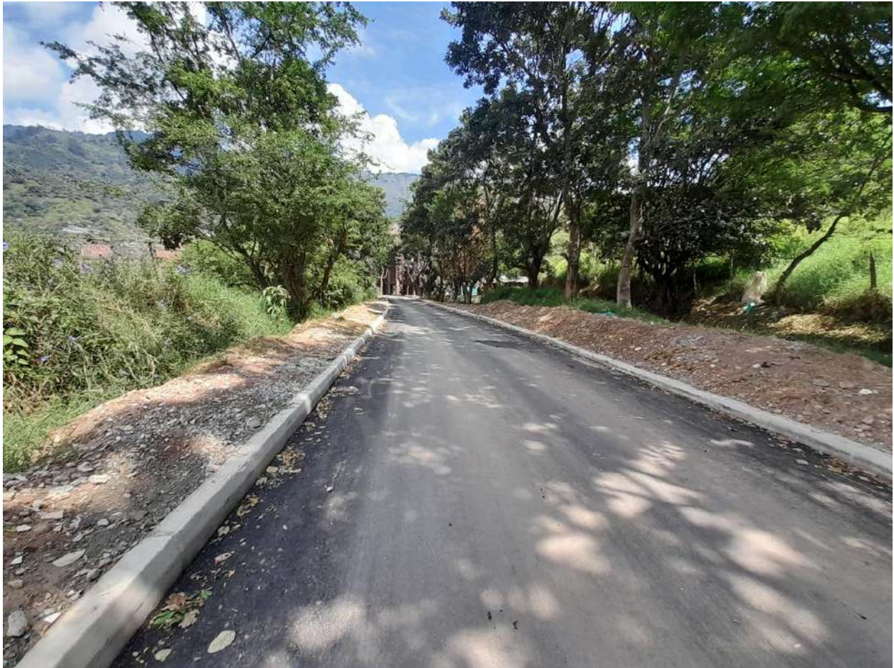
Figura 20: Estado final de la vía pavimentada.
