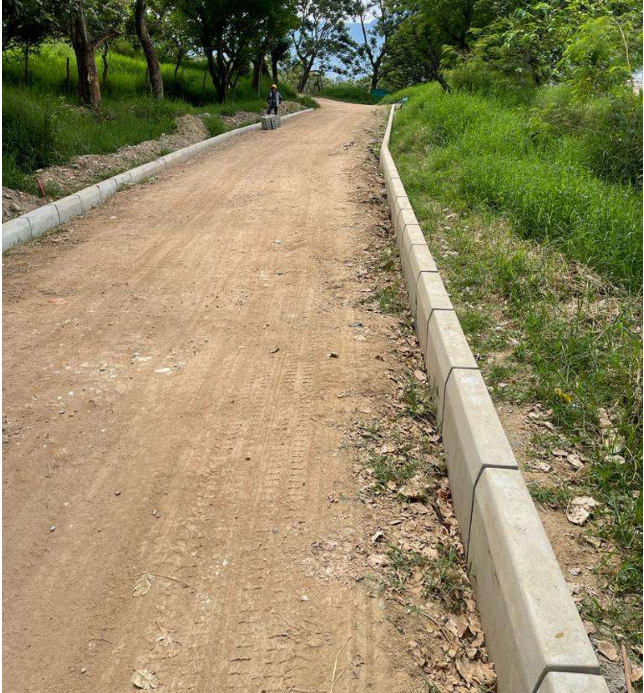
Figura 14: Instalación de cordonería tramo final vía a pavimentar.
