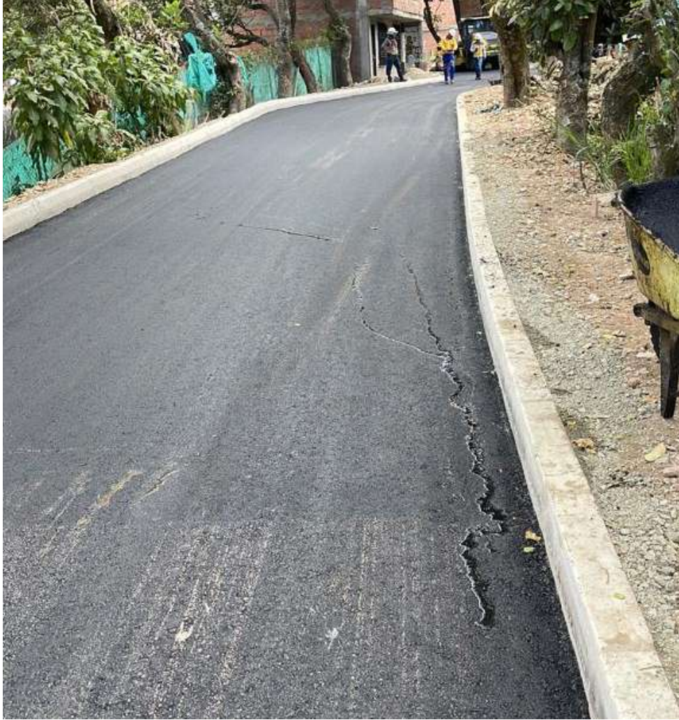
Figura 19: Evidencia de agua fluyendo en dirección de las pendientes diseñadas.
