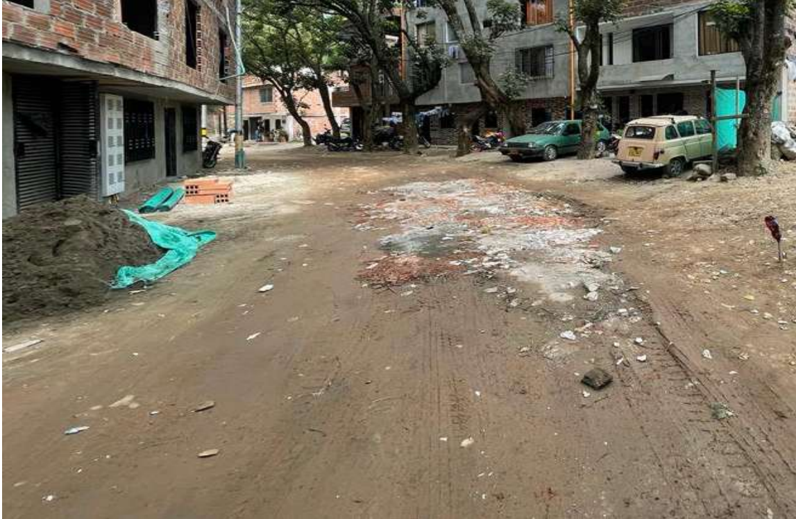
Figura 9: Terreno inicial punto más alto tramo a pavimentar.
