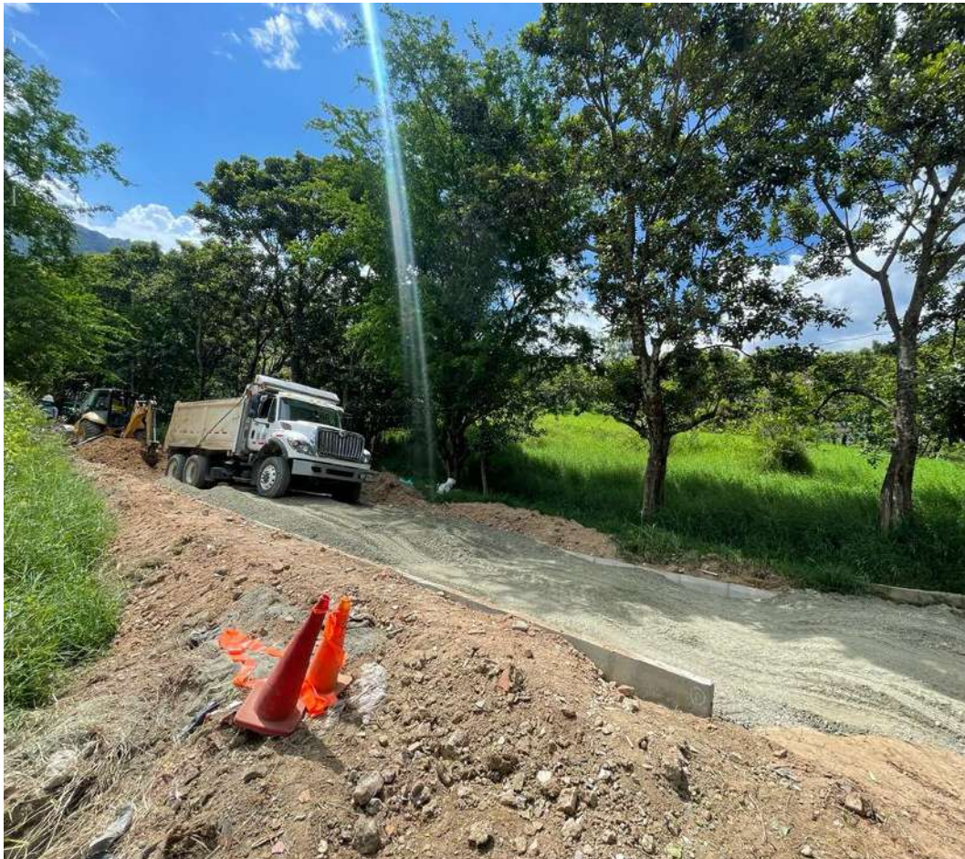
Figura 16: Cajeo, nivelación e instalación de base granular.
