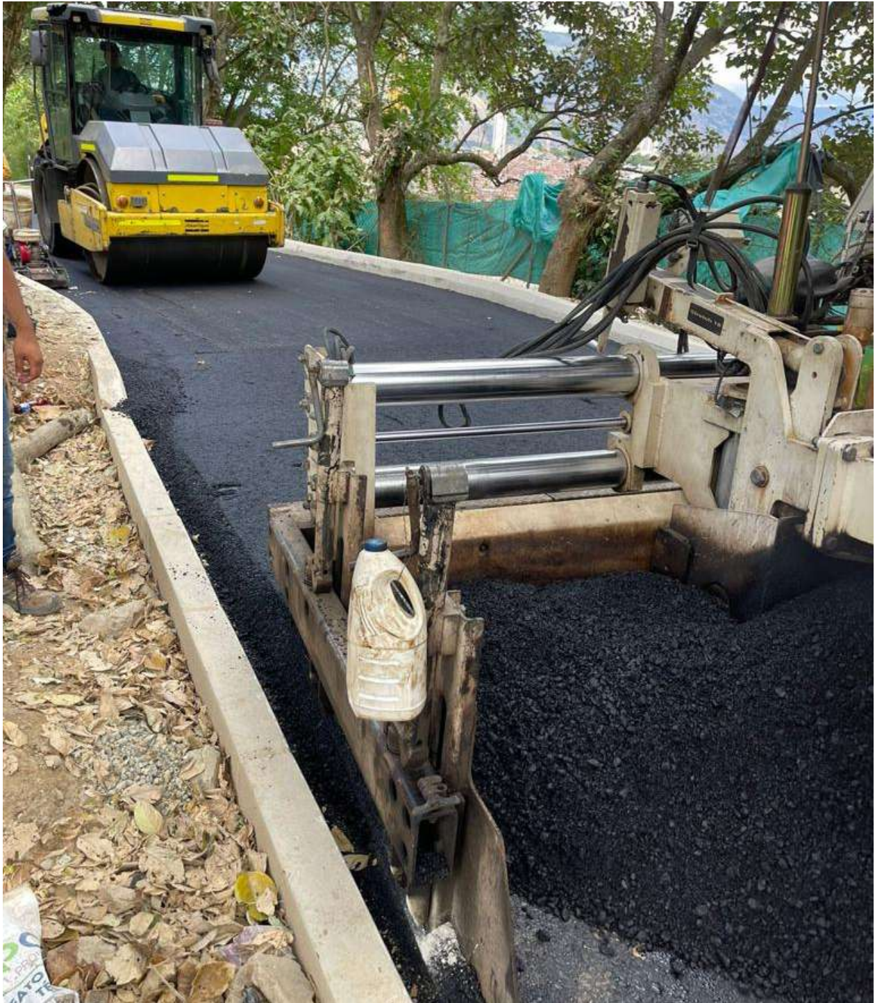
Figura 18: Instalación, compactación y nivelación de carpeta asfáltica.
