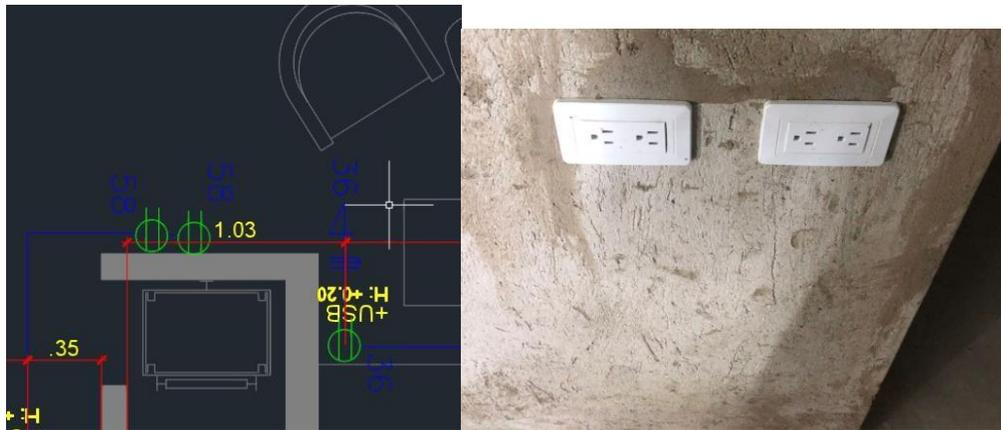
Figura 39. Instalación de salidas eléctricas local comercial mezanine.
