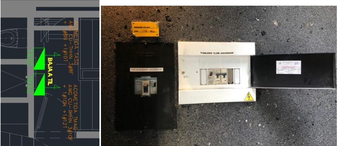
Figura 54. Tableros de ascensores y de iluminación de ascensores.
