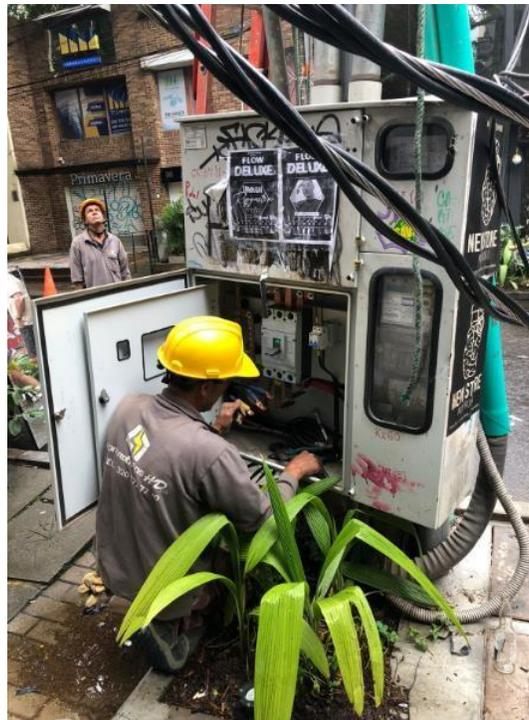
Figura 12. Montaje de gabinete de medida Provisional.
