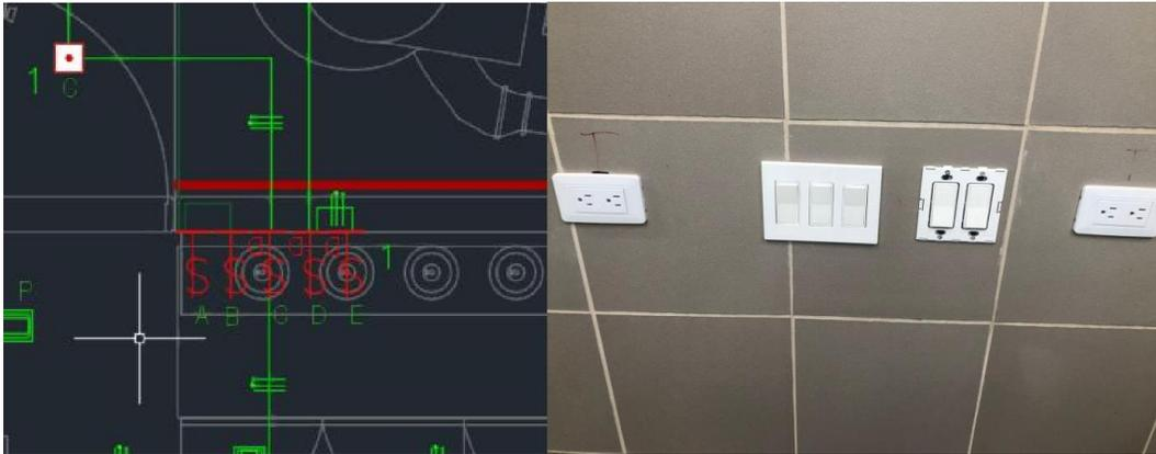
Figura 38. Instalación de salidas eléctricas local comercial sótano 1.
