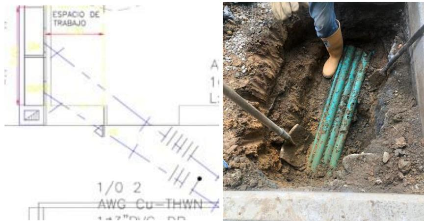
Figura 7. Canalización de energía por Anden.
