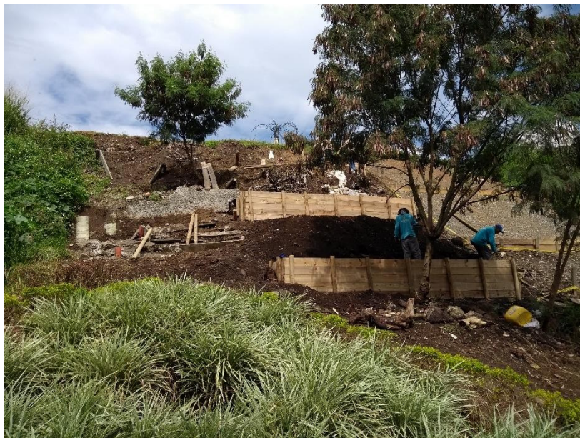
Fig. 14. Adecuación e instalación de los trinchos
