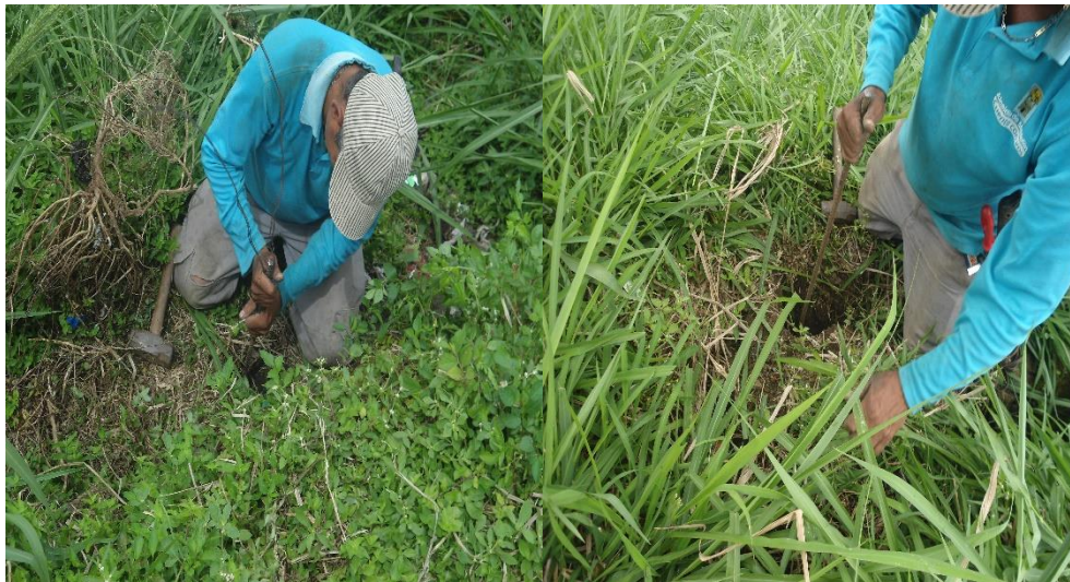
Fig. 17. Perforaciones en masa de residuos
