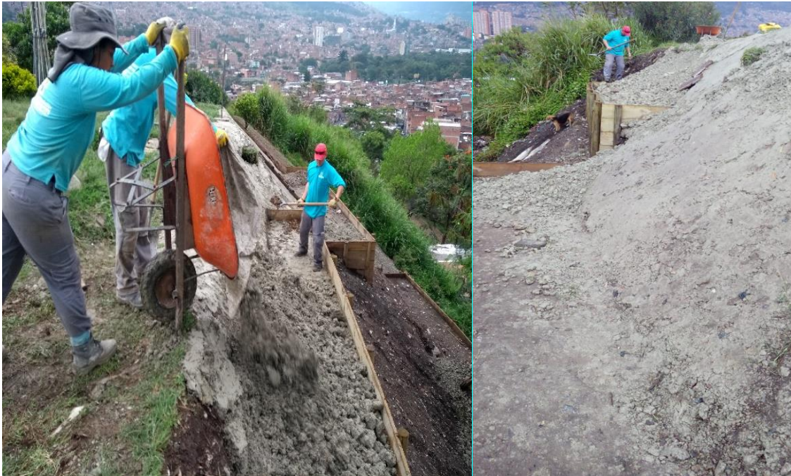
Fig. 45. Disposición y compactación material de cobertura
