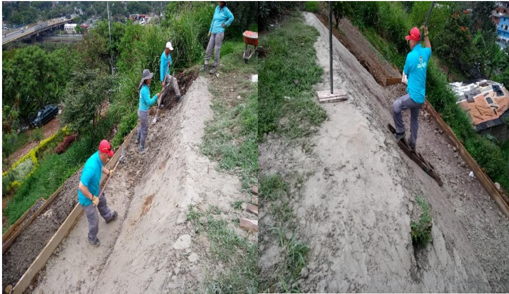
Fig. 16 Compactación manual
