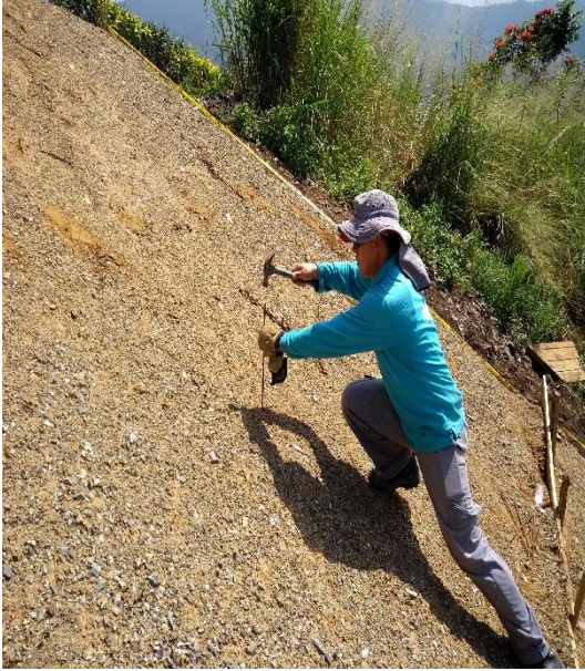
Fig. 11. Instalación puntos de medición parcela1
