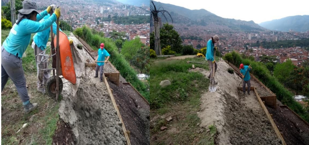
Fig. 15. Disposición material de cobertura
