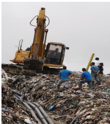
Fig. 35. Excavación masa de residuos. [66]
