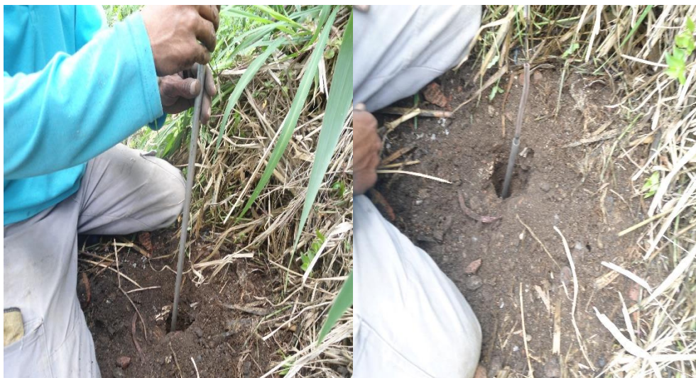
Fig. 18. Instalación maguera de medición
