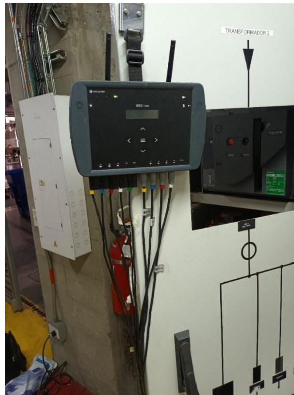
Fig. 12 Sensores de corriente
