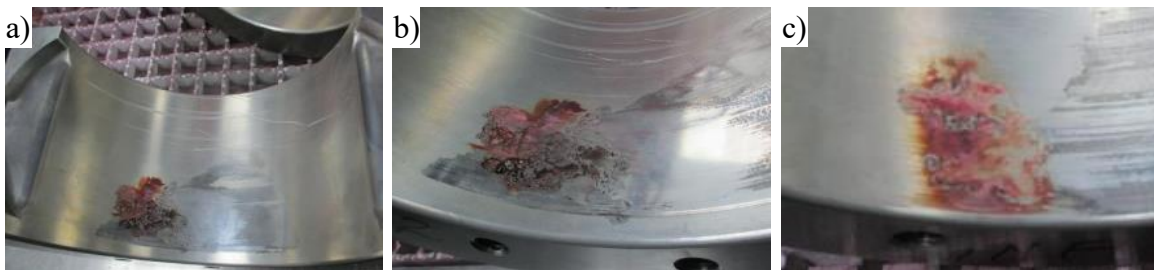
Figura 25. Inspección inicial de los cojinetes.
