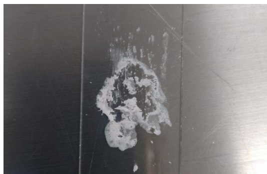
Fig. 3. Par resina solvente de PVC en agua.
