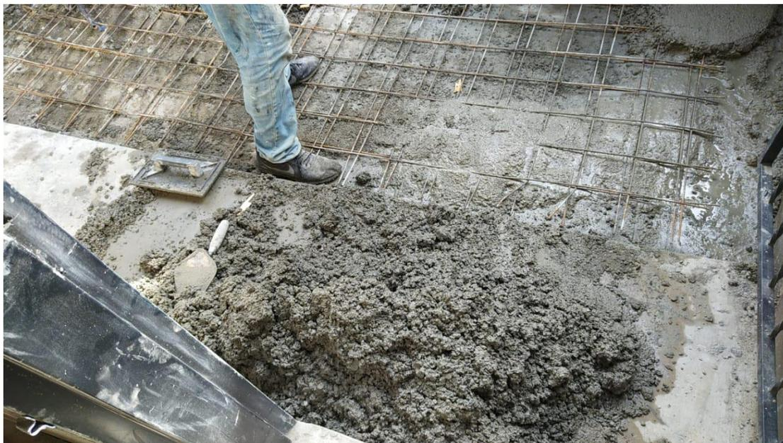
**Fotografía 19.** Visita al lugar de trabajo de un migrante ejerciendo el oficio de albañil. Instalación de una malla electrosoldada para posteriormente vaciar la mezcla de cemento, 7 de febrero de 2022. Fotografía de Alexander Hoyos.
