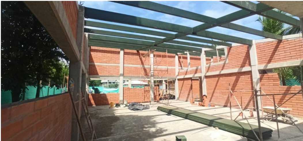
Figura 20. Perfiles metálicos soporte cubierta.
