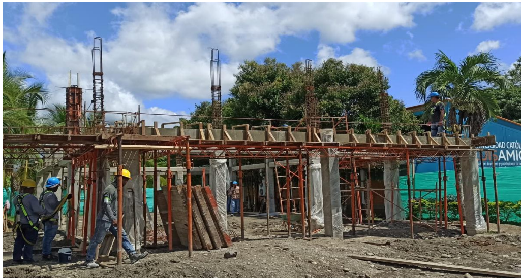
Figura 18. Enconfrado de vigas aéreas.
