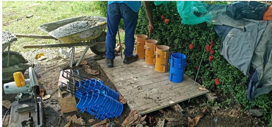
Figura 21. Toma de cilindros de concreto para ensayo de resistencia a compresión.
