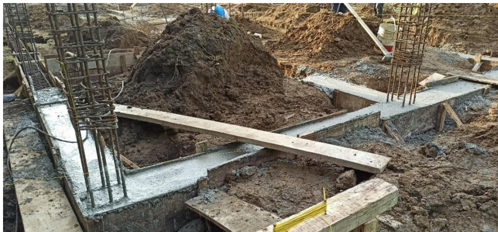
Figura 16. Vaciado viga fundación
