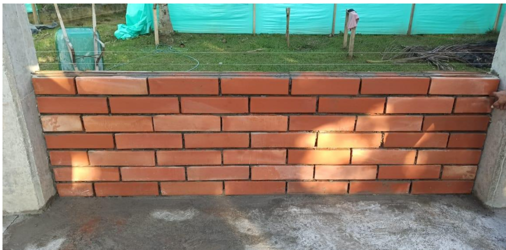
Figura 19. Mampostería catalana, grafiles de refuerzo y anclaje barra.
