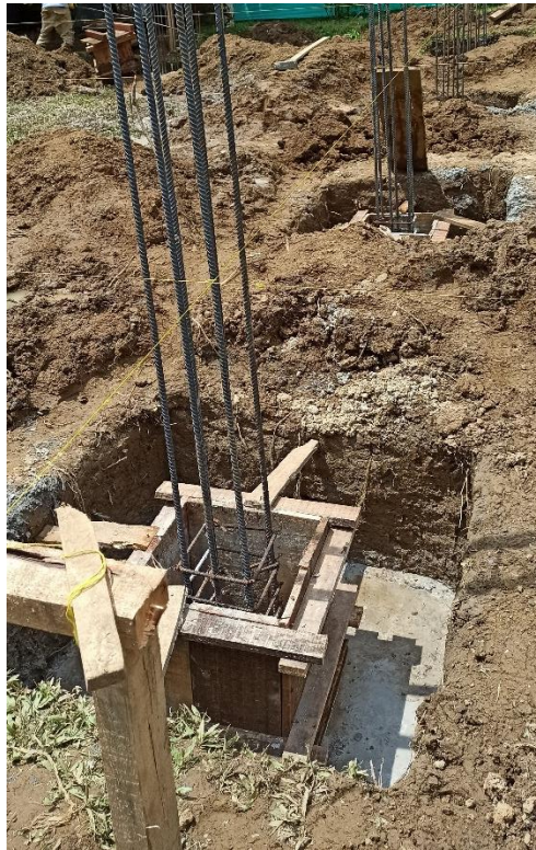
Figura 14. Encofrado pedestal.
