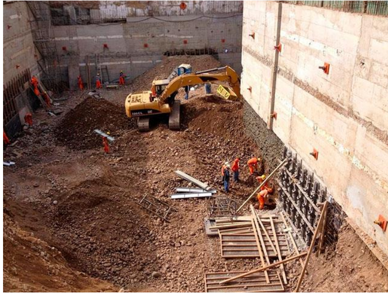
Figura 5. Muro de pantalla
