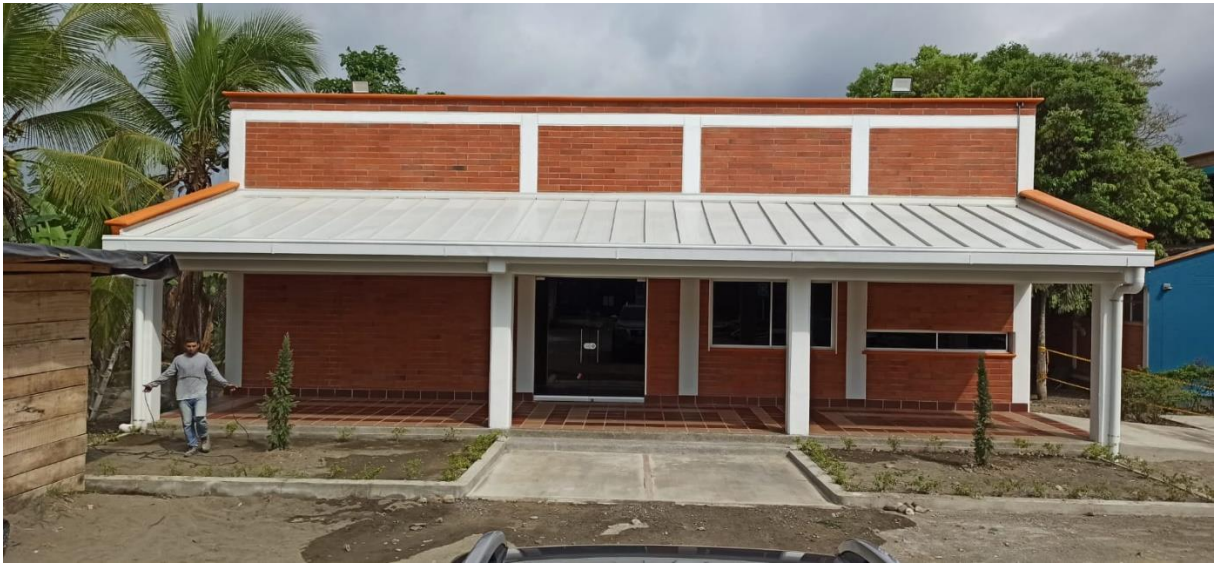
Figura 26. Fachada final frente salon docentes.
