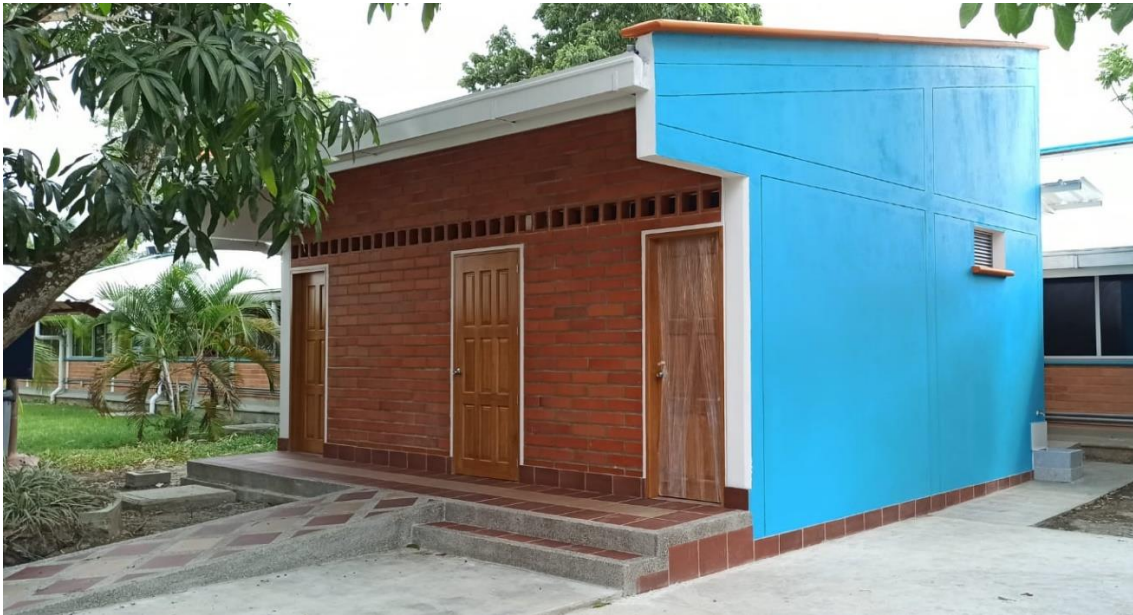
Figura 28. Fachada frontal salón coordinación.
