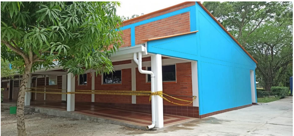
Figura 27. Fachada frontal salón coordinación.
