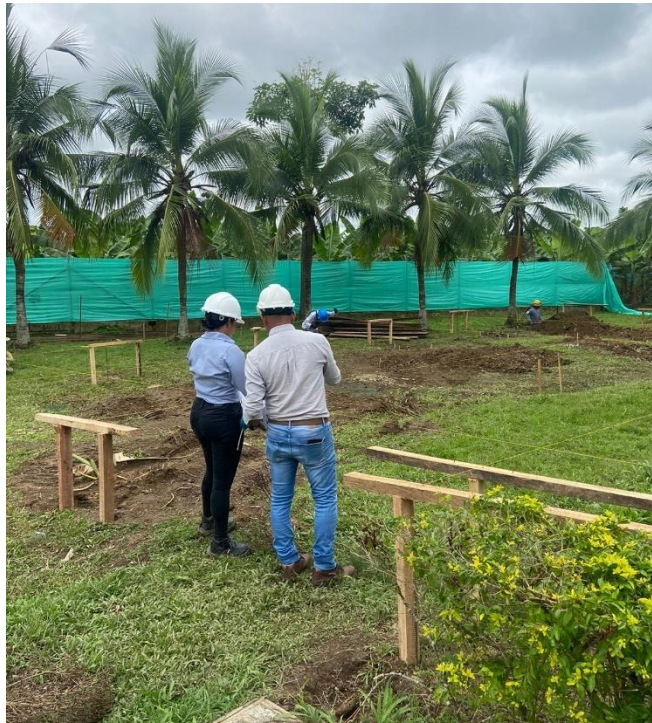
Figura 11. Replanteo obra.
