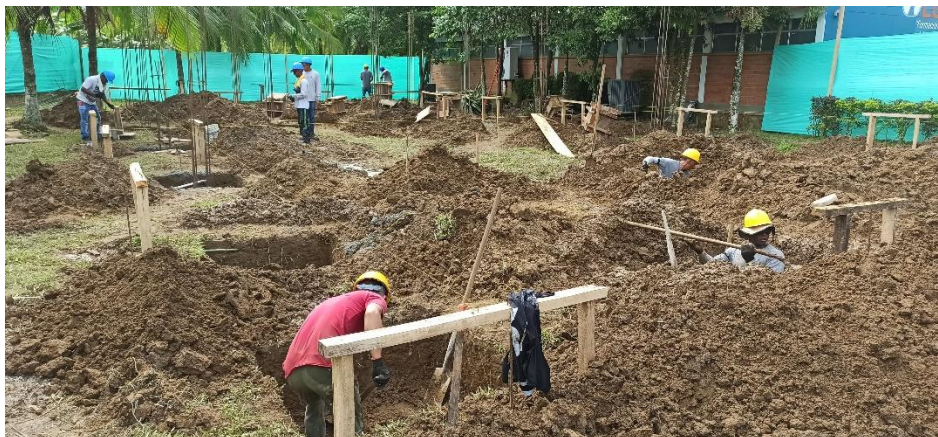
Figura 12. Replanteo y excavación de zapatas de fundación.
