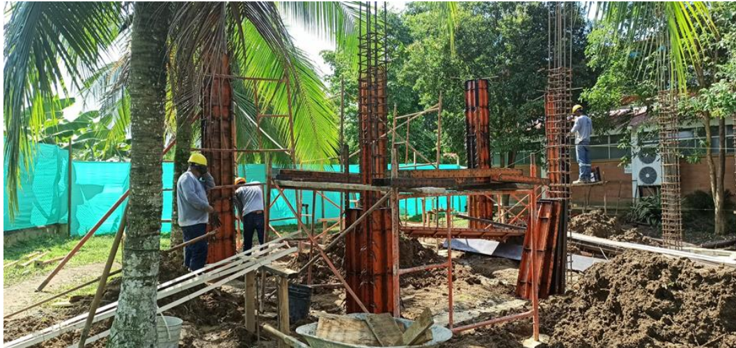
Figura 17. Encofrado y vaciado de columnas 30x30.
