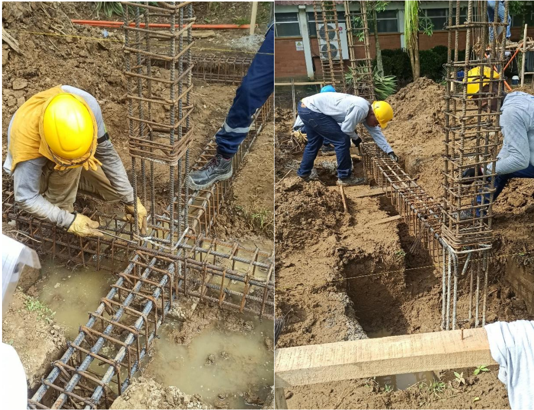
Figura 15. Armado acero de refuerzo en viga de fundación.
