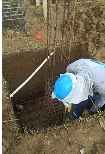
Figura 13. Acero de refuerzo para zapatas y columnas
