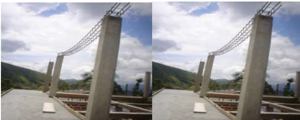
Fotografía 2: Columnas y vigas de la casa que a modo de metáfora une la estrategia uno con la dos. Autor: Juan Carlos Pabón
