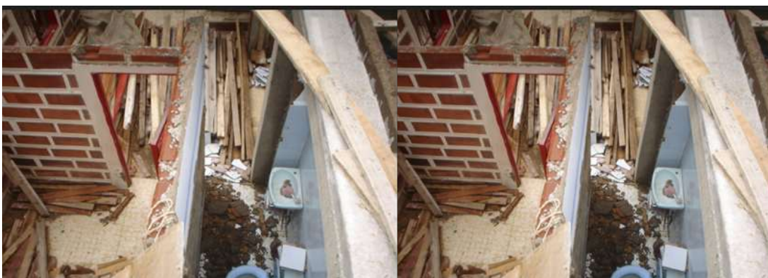
Fotografía 6: El piso de la casa del primer piso durante la construcción. Autor Juan Carlos Pabón
