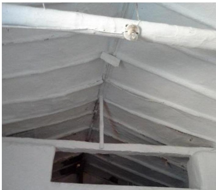
Foto 9. Estructuras de la cubierta o techo de viviendas tradicionales construidas en tapia. Fotografías María Teresa Arcila, 2018
