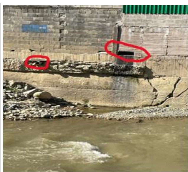
Ilustración 22. Empresas con presunta disposición de ARnD directo al cauce de la quebrada
