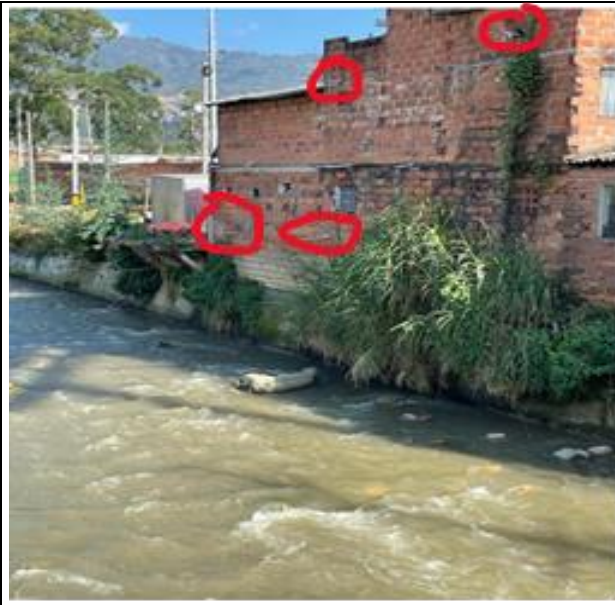
Ilustración 26. Viviendas asentadas en la ribera de la quebrada Doña María
