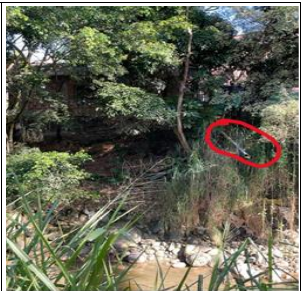
Ilustración 11. Desagües de locales comerciales directamente al cauce de la quebrada
