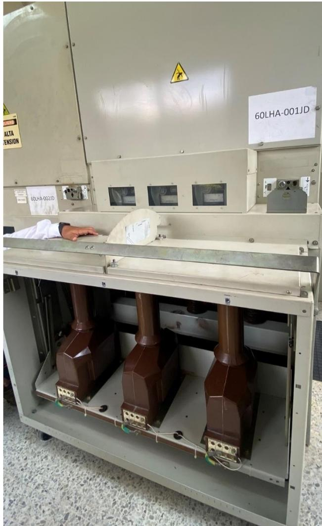
Figura 27. Envoltorio de expansión instalado en la celda vecina 60LHA-001JD.
