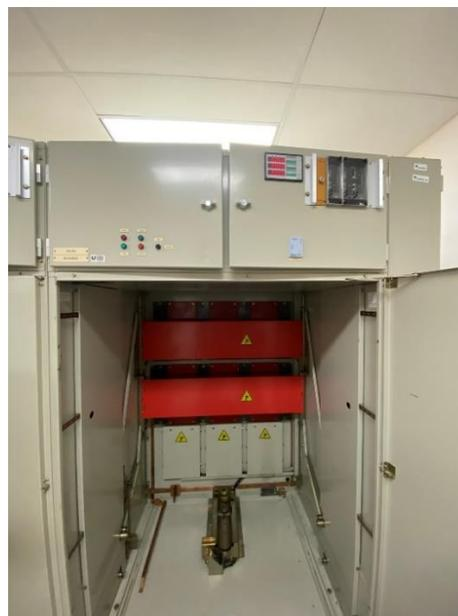
Figura 19. Zona 1: Espacio frontal de la celda de conexión con vista frontal del cubículo de control.
