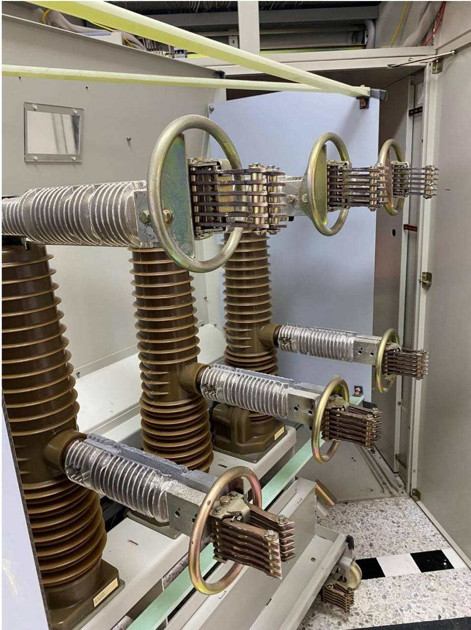
Figura 14: Registro fotográfico de disyuntor existente.
