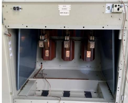
Figura 23. Zona 2: Detalle ampliado del compartimiento para los transformadores de corriente.
