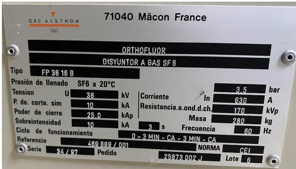
Figura 15: Ficha de especificaciones técnicas de disyuntor existente.
