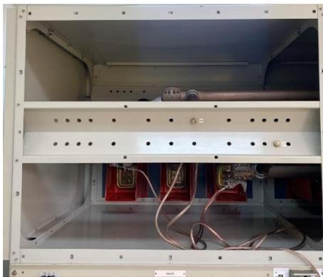
Figura 22. Zona 2: Compartimiento de las terminales superiores del interruptor.
