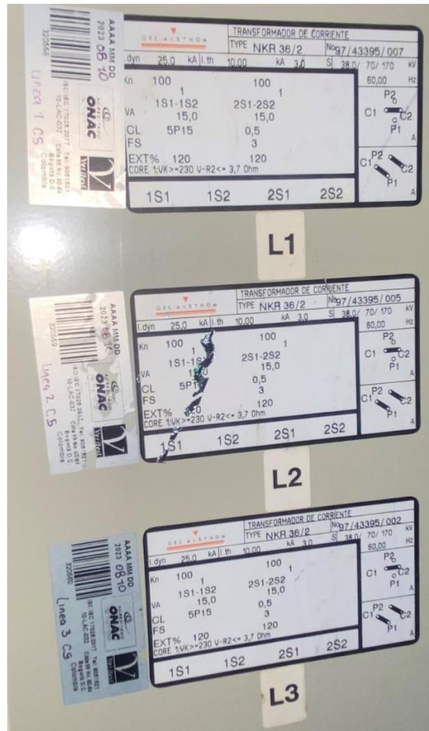
Figura 11: Especificaciones técnicas transformador de corriente existente.
