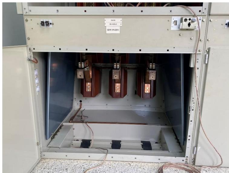
Figura 10: Transformador de corriente existente.
