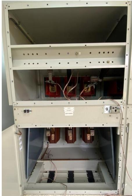
Figura 21. Zona 2: Compartimiento de los transformadores de corriente.
