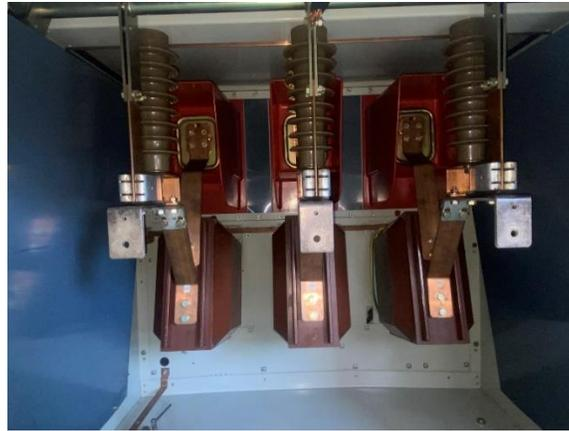
Figura 25. Zona 2: Detalle de los terminales inferiores del interruptor en la zona de los transformadores de corriente.
