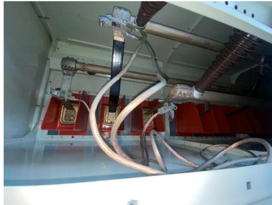
Figura 24. Zona 2: Detalle ampliado del compartimiento con las terminales superiores del interruptor.
