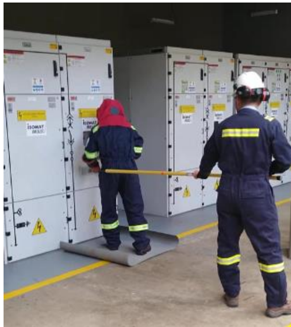
Fig. 2. Actividad de energía cero en celda de media tensión.
