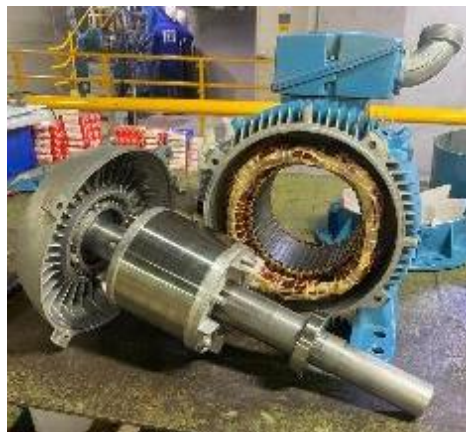
Fig. 13. Cambio de rodamiento en motores.
