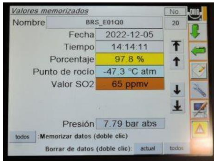
Fig. 20. Calidad del gas SF6.
