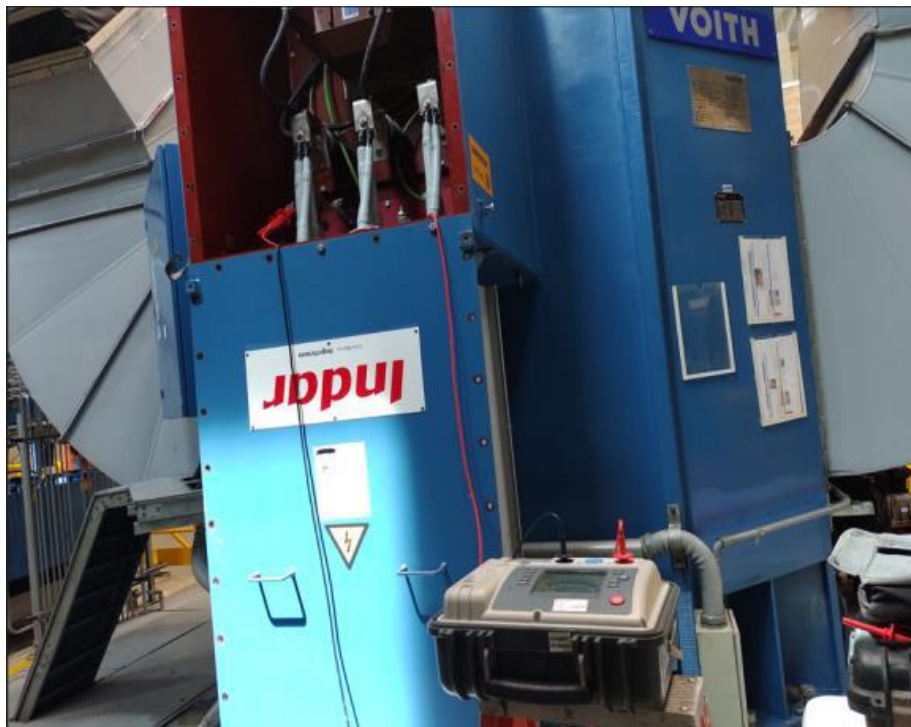
Fig. 3. Prueba de aislamiento al generador
