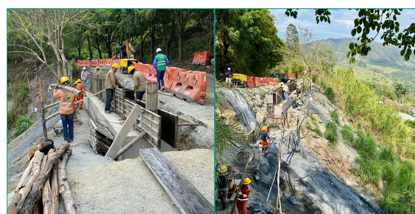
Muro de contención sobre pilas
