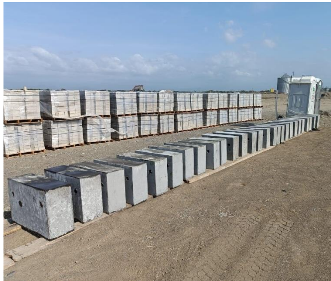
Figura 13. Acopio de bordillos.
