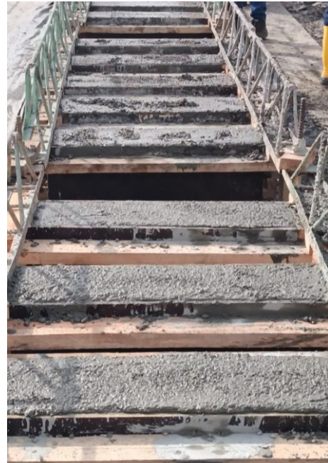
Figura 15. Proceso de fundida de bordillos de diseño final
