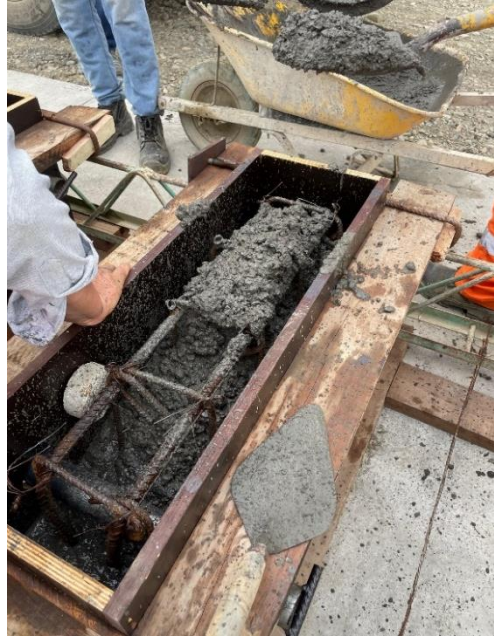
Figura 7. Vaciado de concreto de bordillo de confinamiento con diseño inicial.
