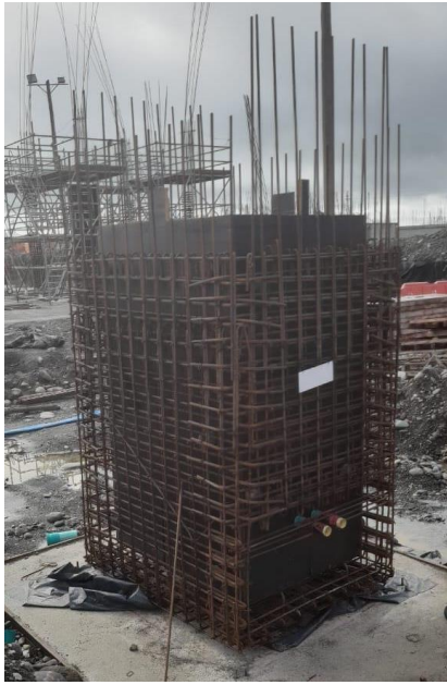
Figura 24. Encofrado de caja eléctrica tipo V.
