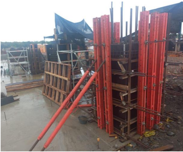
Figura 20. Sistema de encofrado para caja eléctrica tipo IV (1).
