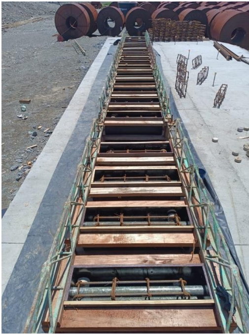
Figura 14. Encofrado de bordillos de diseño final.
