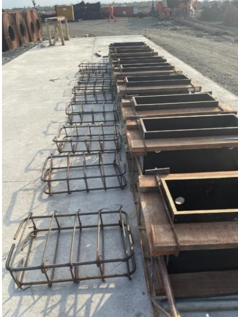
Figura 6. Canasta de acero y encofrado de bordillo con diseño inicial.
