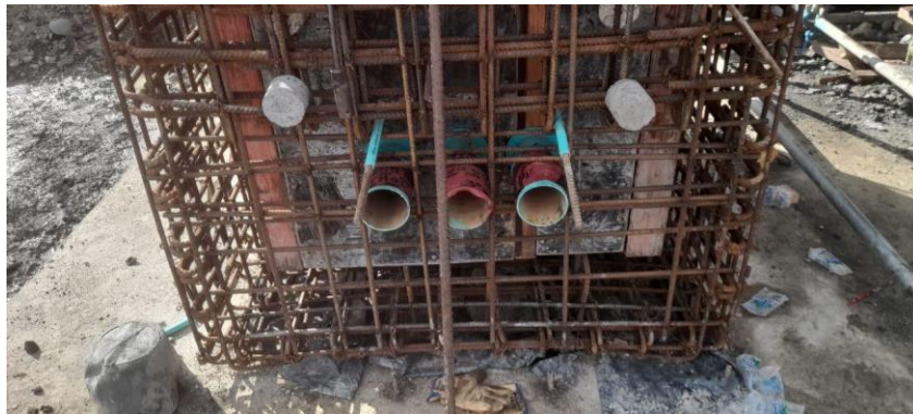
Figura 26. Instalación de banco de ductos de caja eléctrica tipo V.
