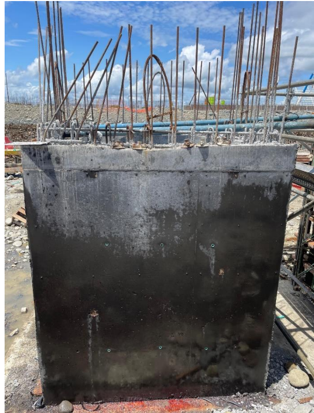
Figura 32. Curado de concreto de caja tipo V empleando antisol rojo.
