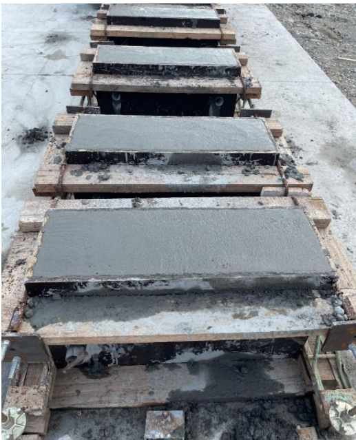
Figura 8. Proceso de acabado del concreto de bordillos de diseño inicial.
