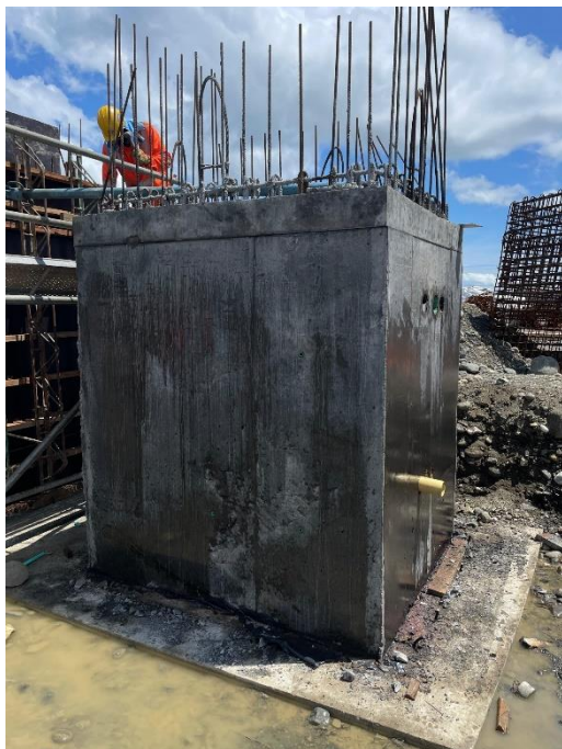
Figura 29. Vista lateral (1) de caja eléctrica tipo V.
