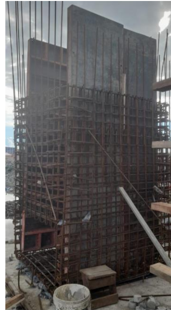
Figura 25. Encofrado interno de caja eléctrica tipo V.
