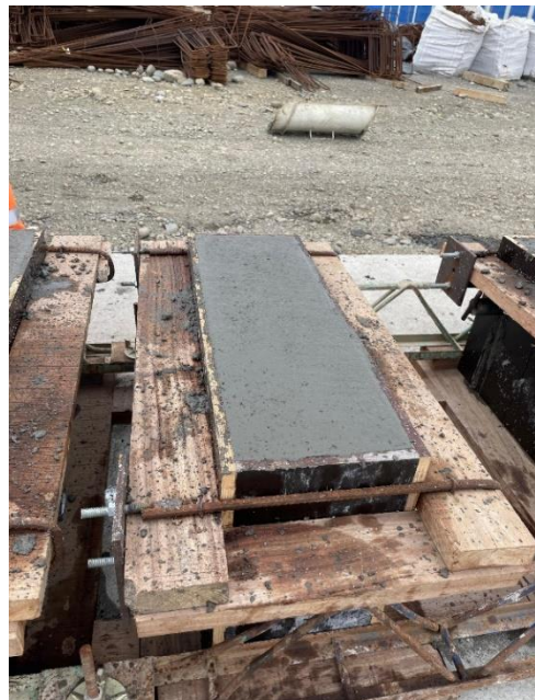
Figura 9. Proceso de endurecimiento del concreto de bordillos con diseño inicial.
