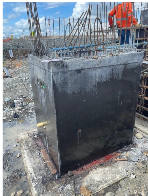
Figura 30. Vista lateral (2) de caja eléctrica tipo V.
