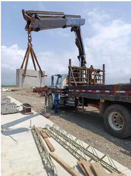
Figura 12. Izaje de bordillo para transporte.
