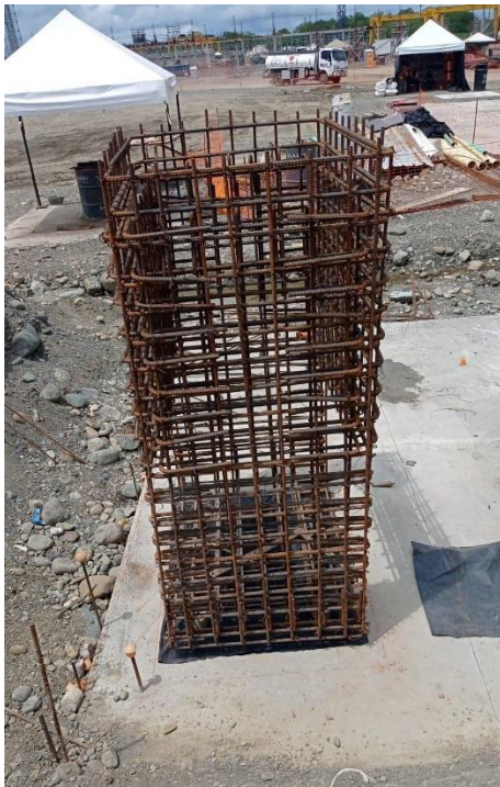
Figura 18. Canasta de acero de caja eléctrica tipo IV.
