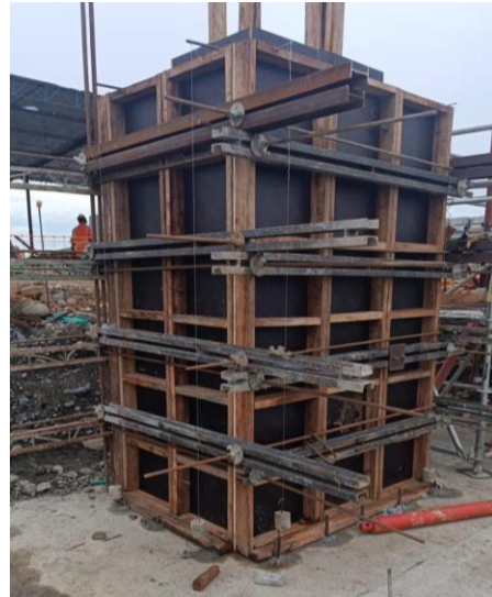
Figura 21. Sistema de encofrado para caja eléctrica tipo IV (2).
