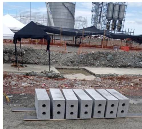
Figura 17. Acopio de bordillos de nuevo diseño.
