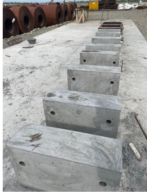
Figura 11. Proceso de curado y desencofrado de bordillos.
