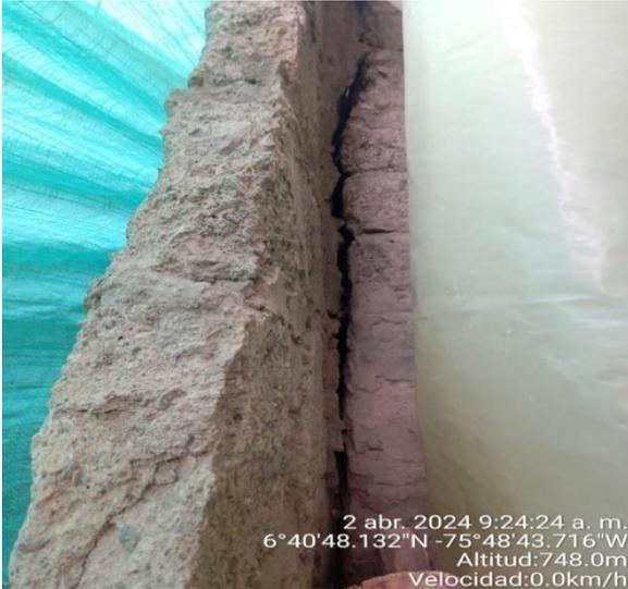
*Ilustración 3. Muro agrietado*
