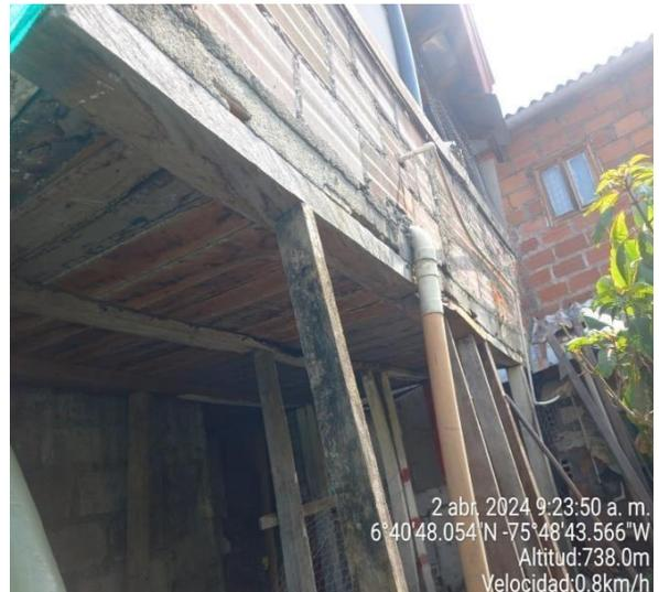
*Ilustración 2. Estructura en madera deteriorada*
